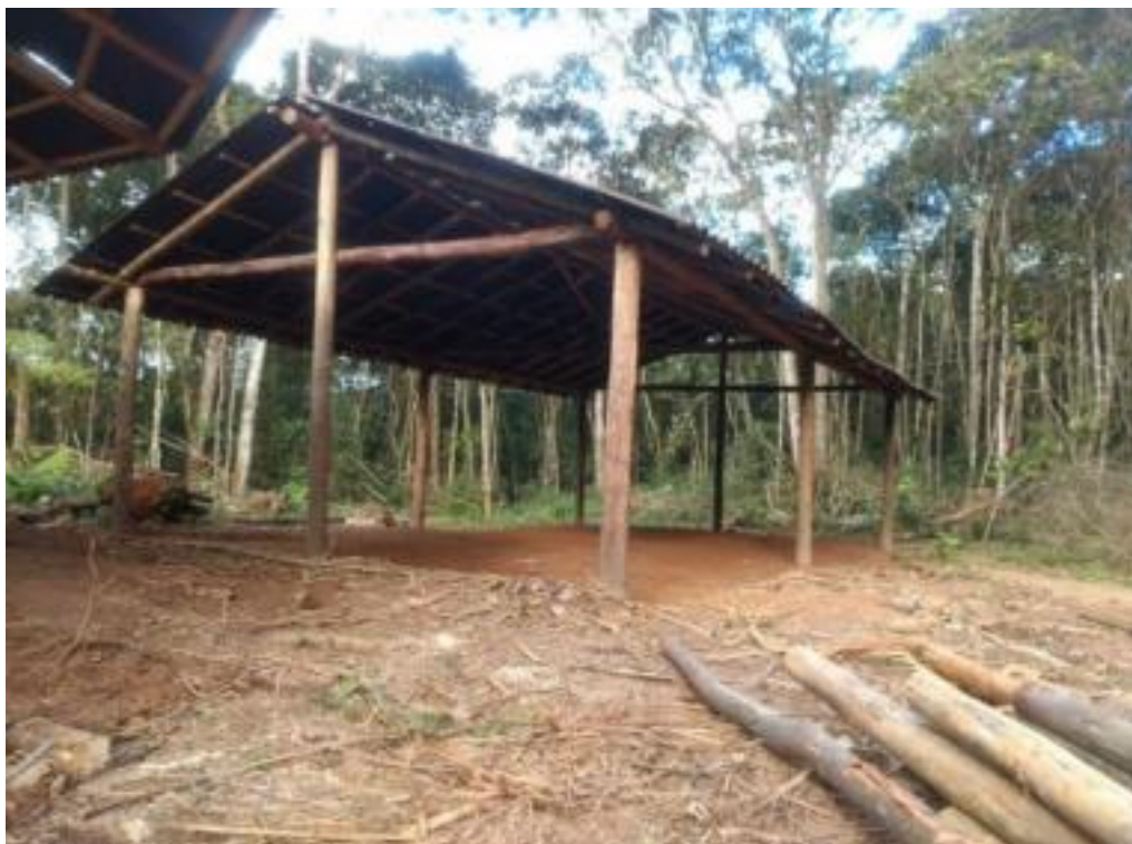
Figura 21 - Aldeia Brilho do Sol - Vivência AUPI e Construção da escola.
