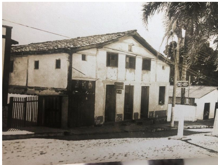
Figura 4: Teatro Sebastião Pompeu de Pina (sem data).
