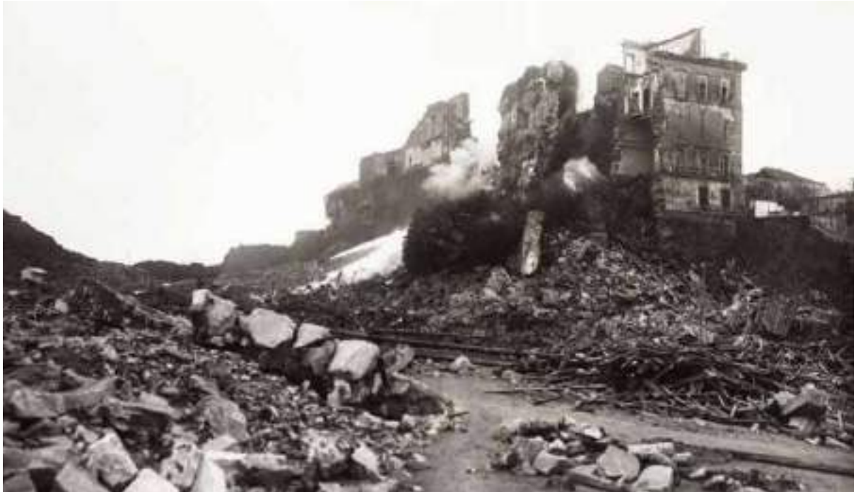
Figura 20: Demolição do Morro do Castelo, no Rio de Janeiro, 1922.
