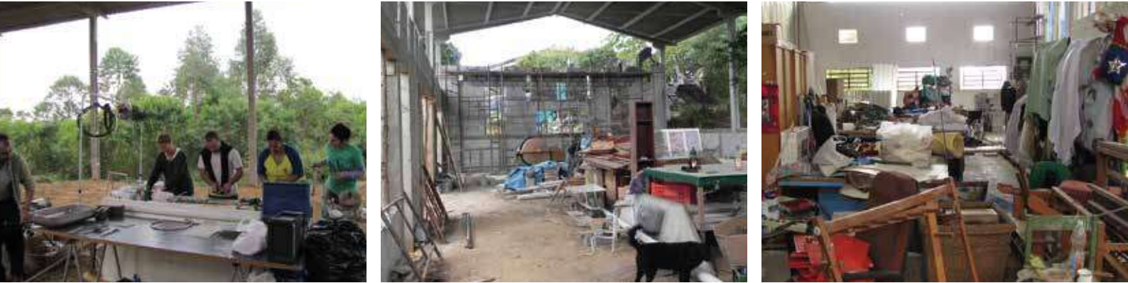
Figuras 24, 25, 26: Registros do processo de construção com a coleta e separação dos materiais para reuso na obra.
