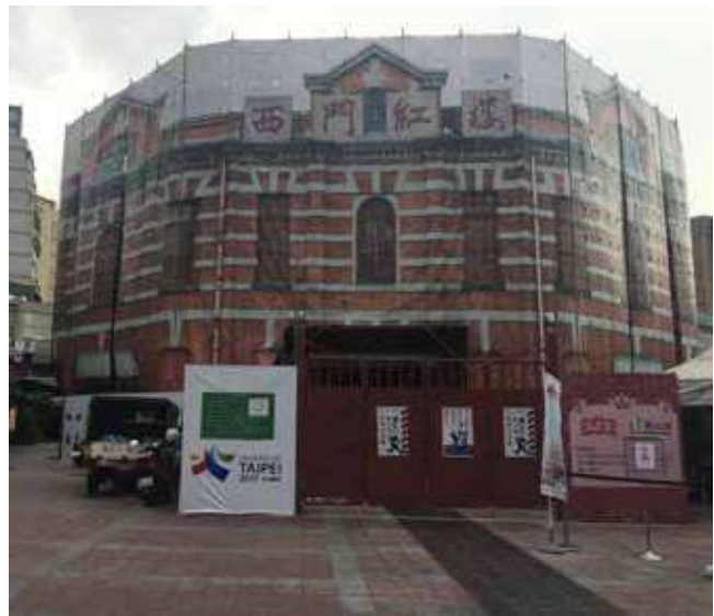
Figura 3: Fachada de edifício em reforma coberto com impressão em tecido do mesmo edifício em escala real (Taipei, 2017).
