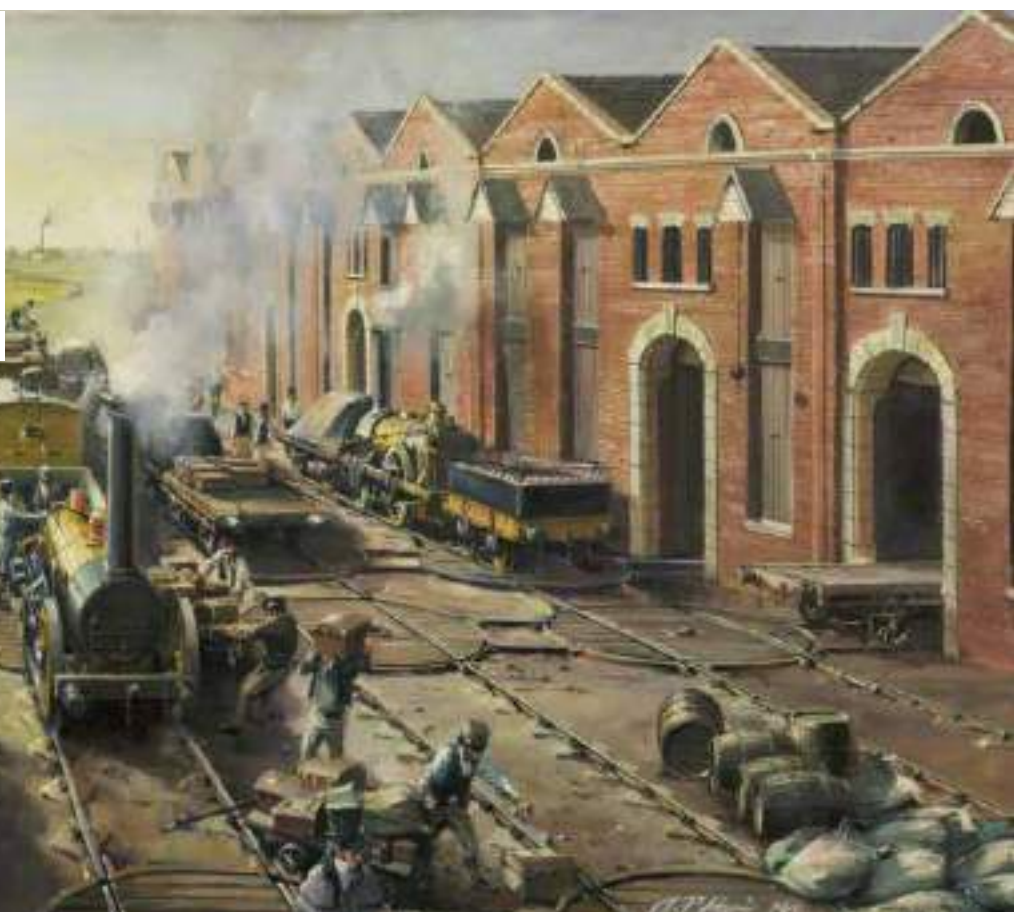
Figura 13: Liverpool Road Station – pintura de Alfred Peter Harris (1932) que mostra o intenso movimento da estação de trem e o descarregamento de mercadorias no armazém.
