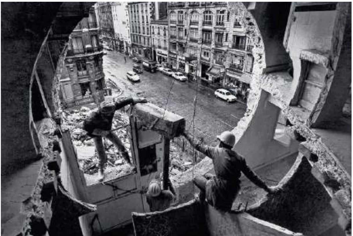
Figura 5: Gordon Matta-Clark e Gerry Hovagimyan trabalhando em “ Conical Intersect ”(1975), em edifício a ser demolido para a construção do Centro Goerges Pompidou, em Beaubourg, Paris.
