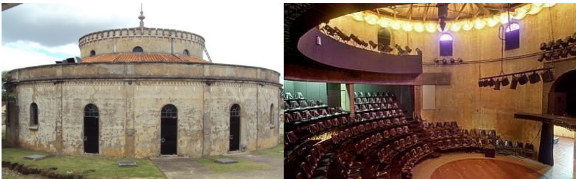
Figura 13 - Imagens externa e interna do Teatro Paiol em Curitiba nas quais é possível visualizar as janelas superiores que iluminavam o palco. Fotos Zig Koch e Eliane Costa.
