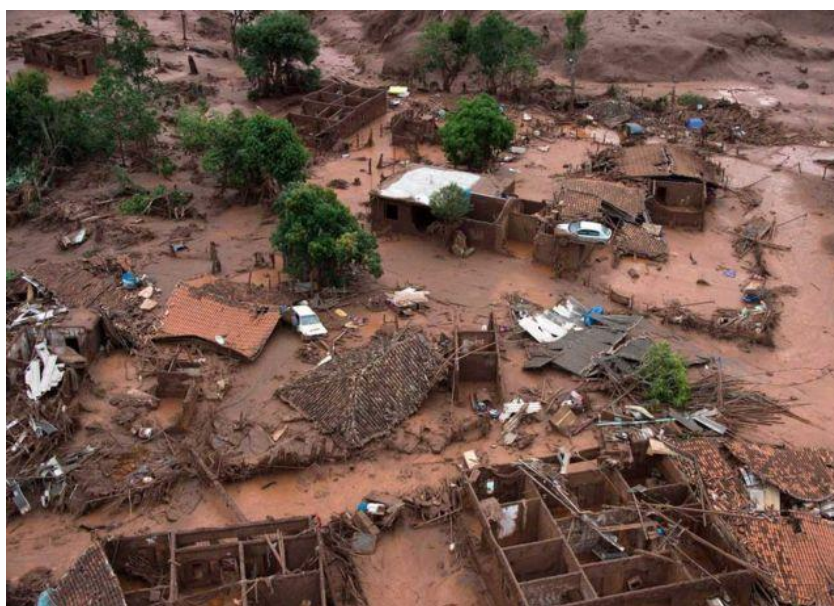
Figura 25. Imagens da cidade de Brumadinho que foi destruída pela Lama do rompimento da barragem do córrego do Feijão, da mineradora Vale.
