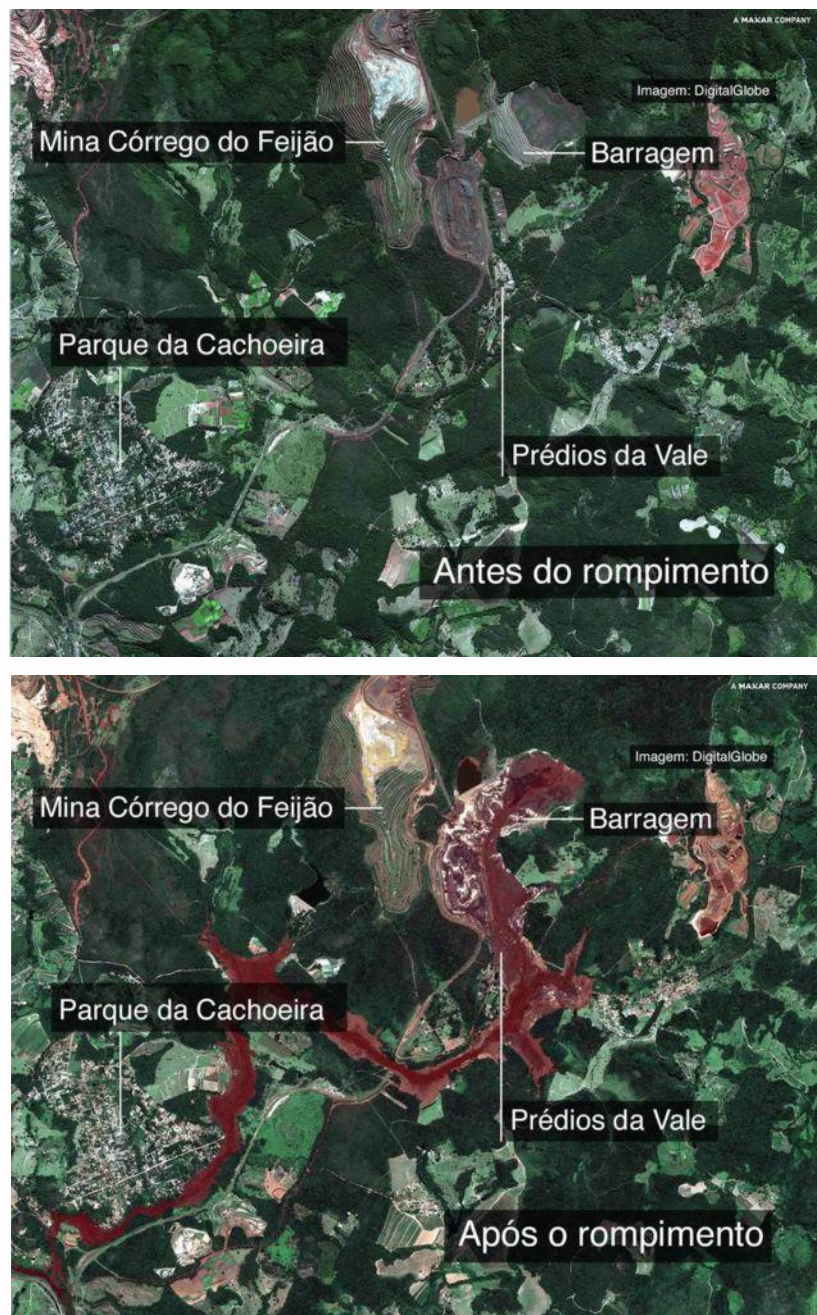
Figura 27. Antes e depois da região na qual ocorreu o rompimento da barragem
