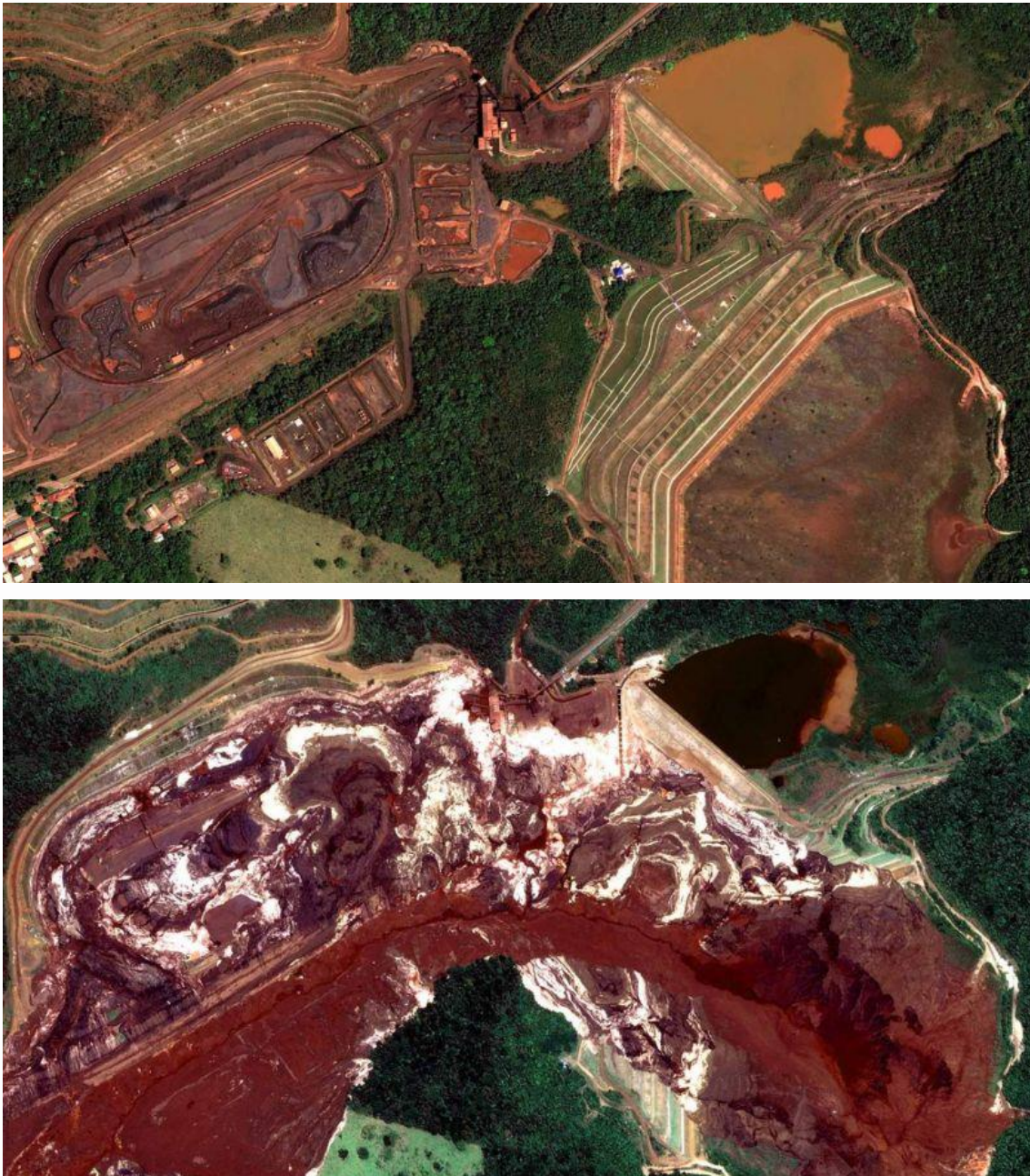
Figura 26. Antes e depois da região na qual ocorreu o rompimento da barragem
