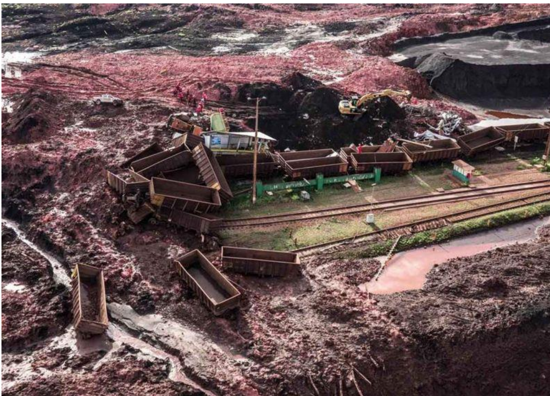
Figura 24. Cena da destruição causada pelo rompimento da barragem
