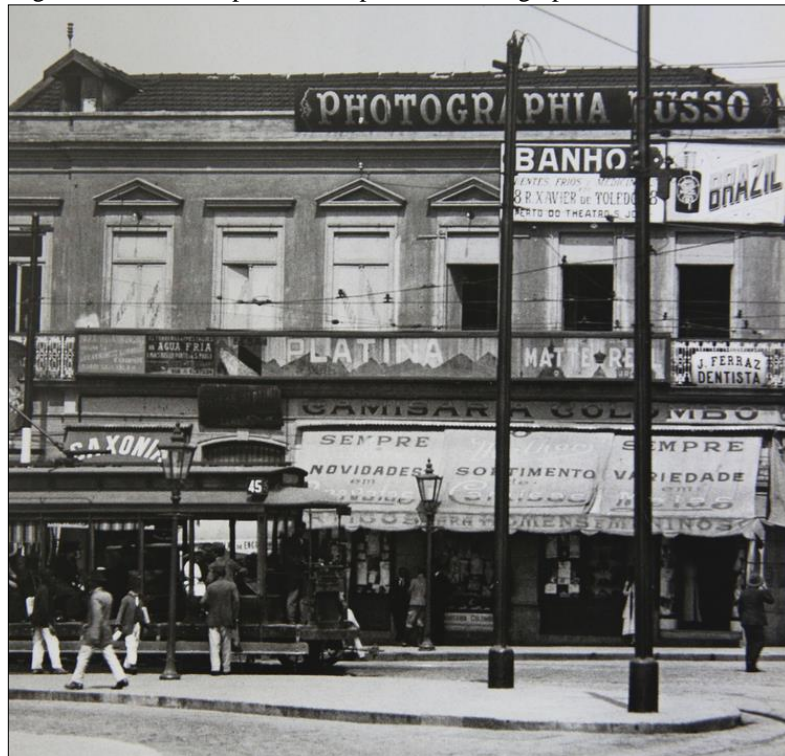
Figura 52 - Vista do prédio com placa do Photographia Russo, São Paulo
