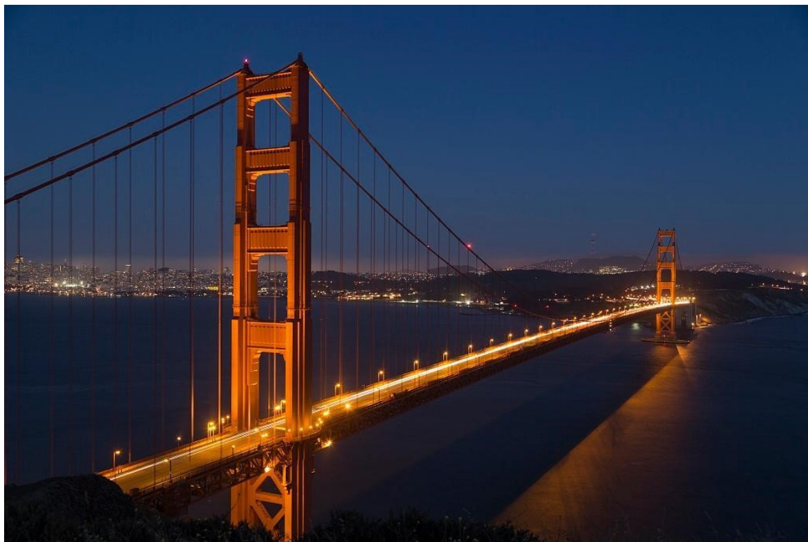
Figura 25 - Ponte Golden Gate.
