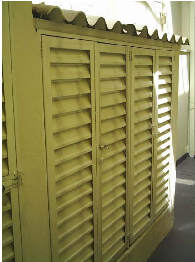
Figura 8. Fachada do abrigo interno de Resíduos de Laboratório de Análises Clínicas de Ribeirão Preto, SP - 2007 Fonte: Silva, 2007.
