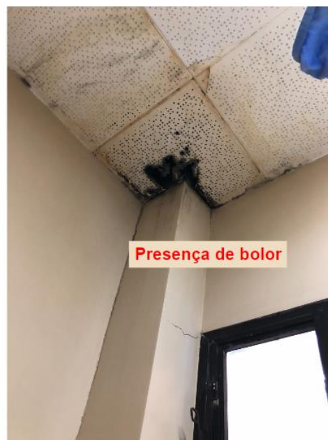
Figura 28 – Dimensionamento do caixilho e presença de bolor no forro. Ribeirão Preto, São Paulo, 2023.
