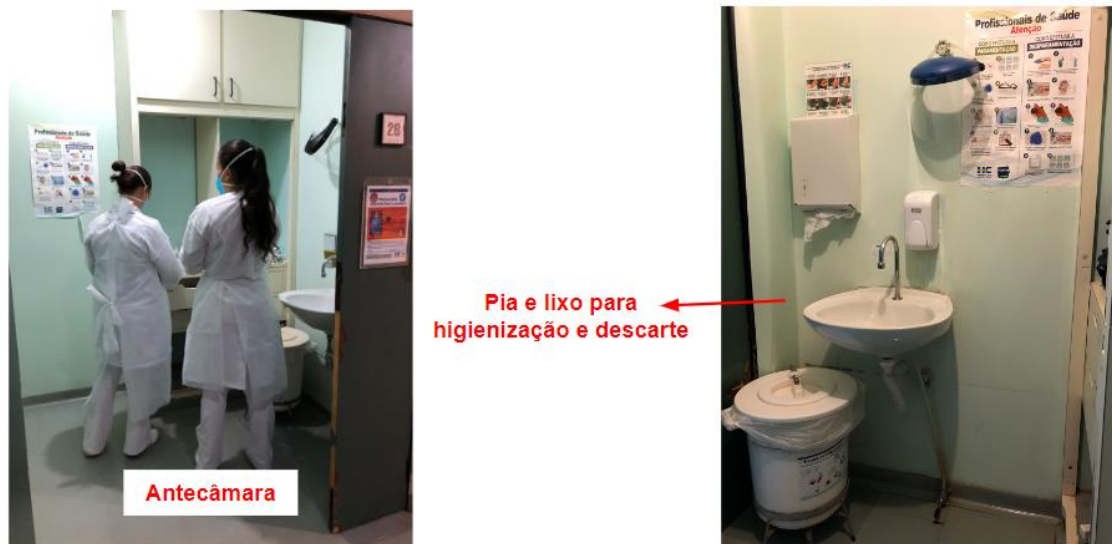
Figura 15 – Antecâmara dos quartos de isolamento da UETDI. Ribeirão Preto, São Paulo, 2023.
