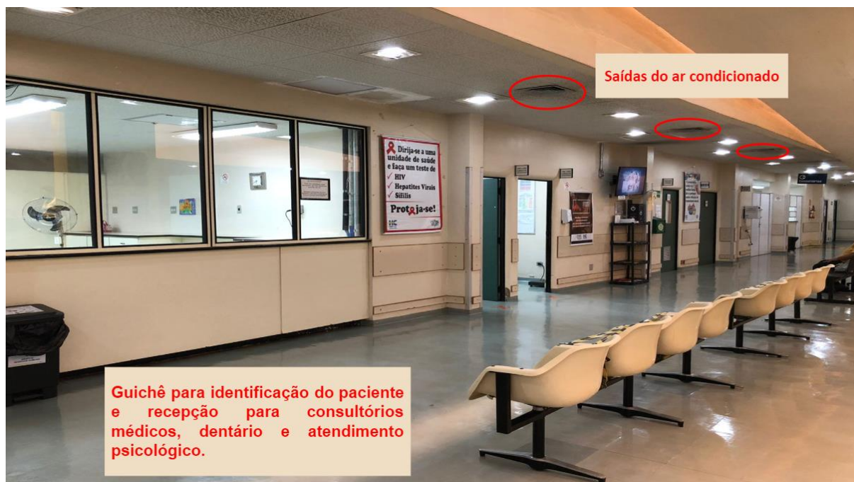
Figura 22 – Localização das saídas de ar condicionado no saguão de espera para consultas ambulatoriais. Ribeirão Preto, São Paulo, 2023.
