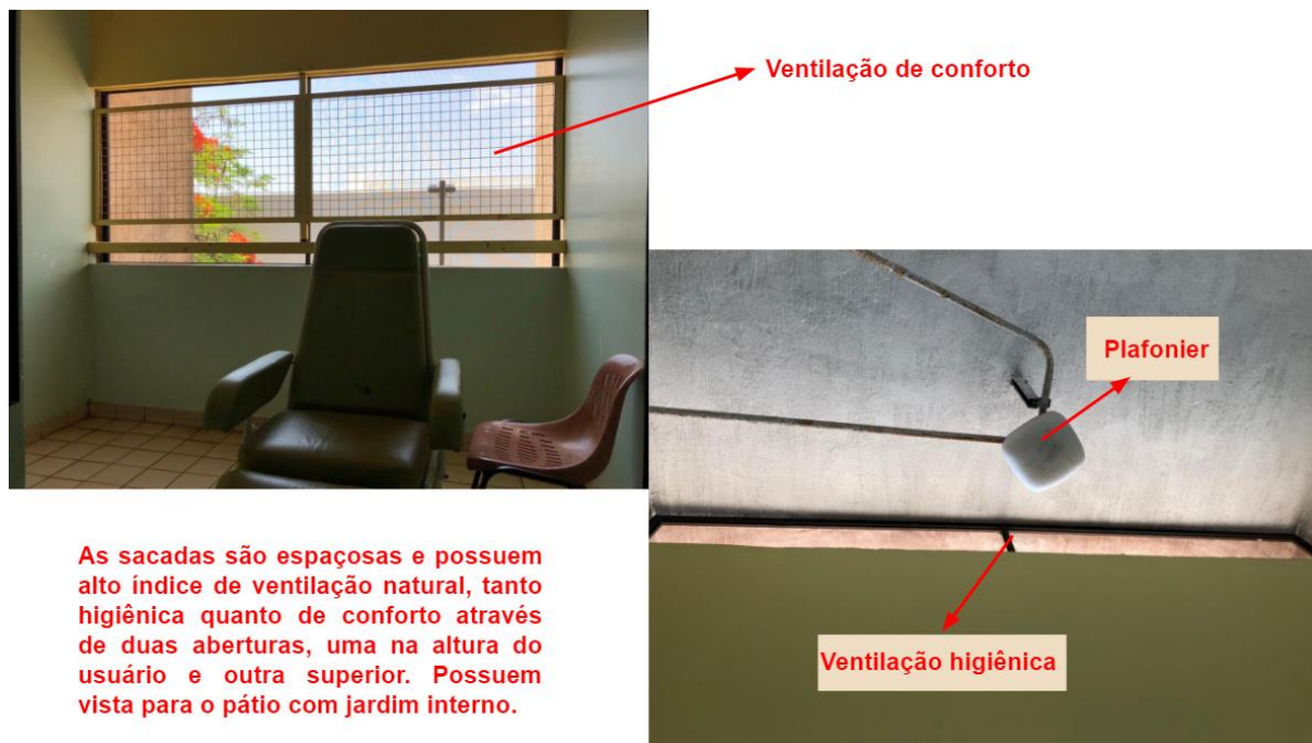
Figura 18 – Ventilação e iluminação natural das sacadas. Ribeirão Preto, São Paulo, 2023.
