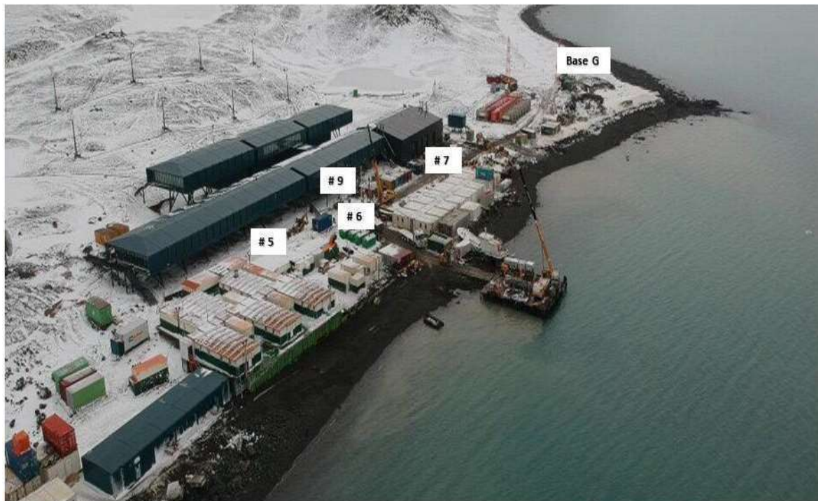
Figura 10 - Pontos de amostragem de solo na área da nova EACF (2017 a 2020)
