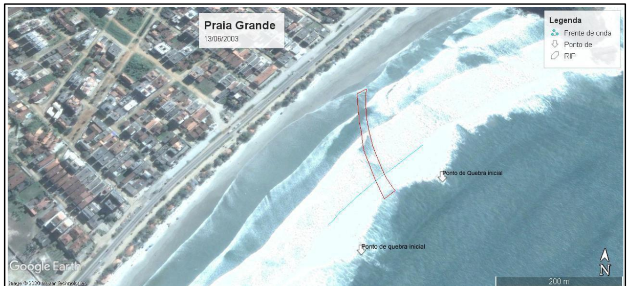
Figura 17 Imagem Google Earth, ilustrando zona de ruptura no raio de quebra de onda.
