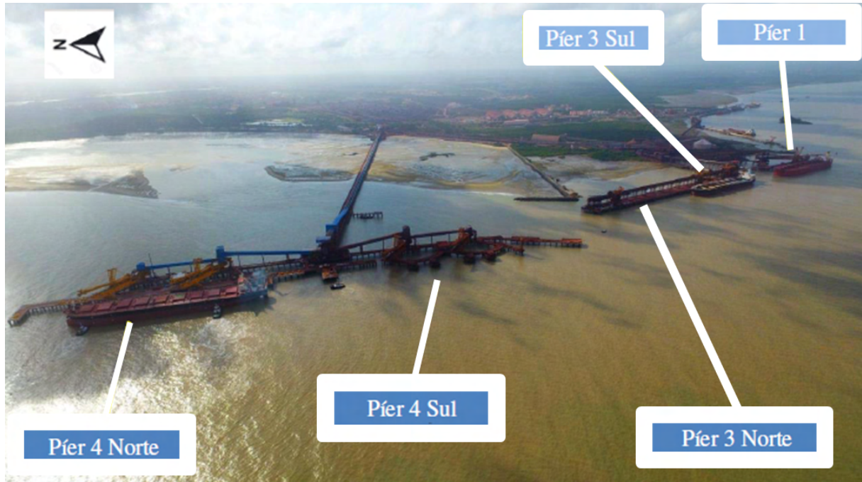
Figura 3: Localização dos píeres de atracação do Terminal Marítimo de Ponta da Madeira - VALE Fonte: Imagem modificada de Magalhães (2018).
