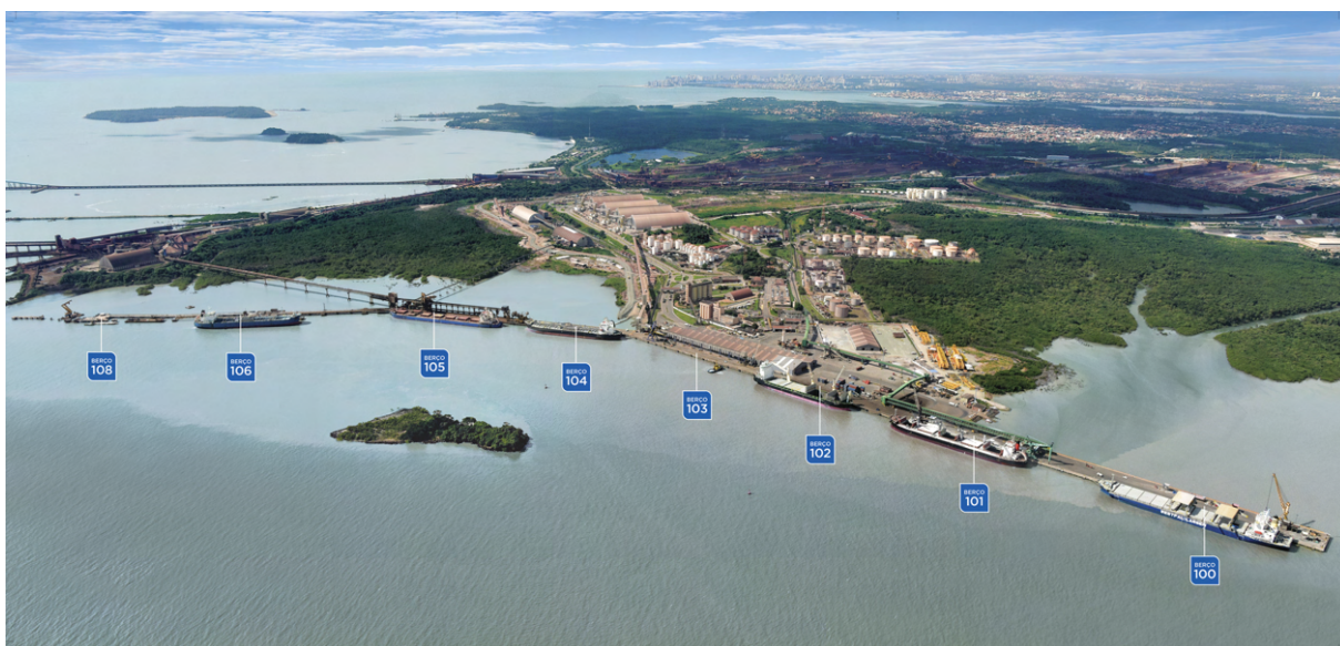
Figura 2: Localização dos berços de atracação do Porto de Itaqui: os berços são enumerados na ordem crescente da direita (berço 100) à esquerda (berço 108) da foto. O berço 99 ainda não estava construído no momento do registro fotográfico (Fonte: portodoitaqui.ma.gov.br).
