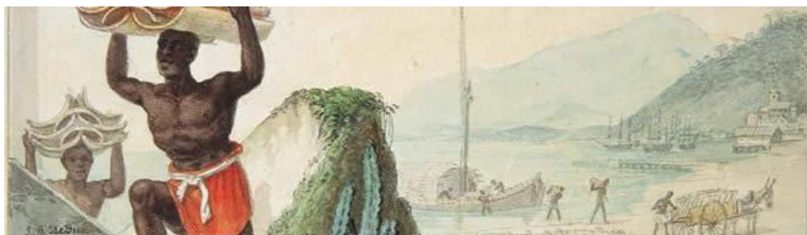
Desembarque de telhas
