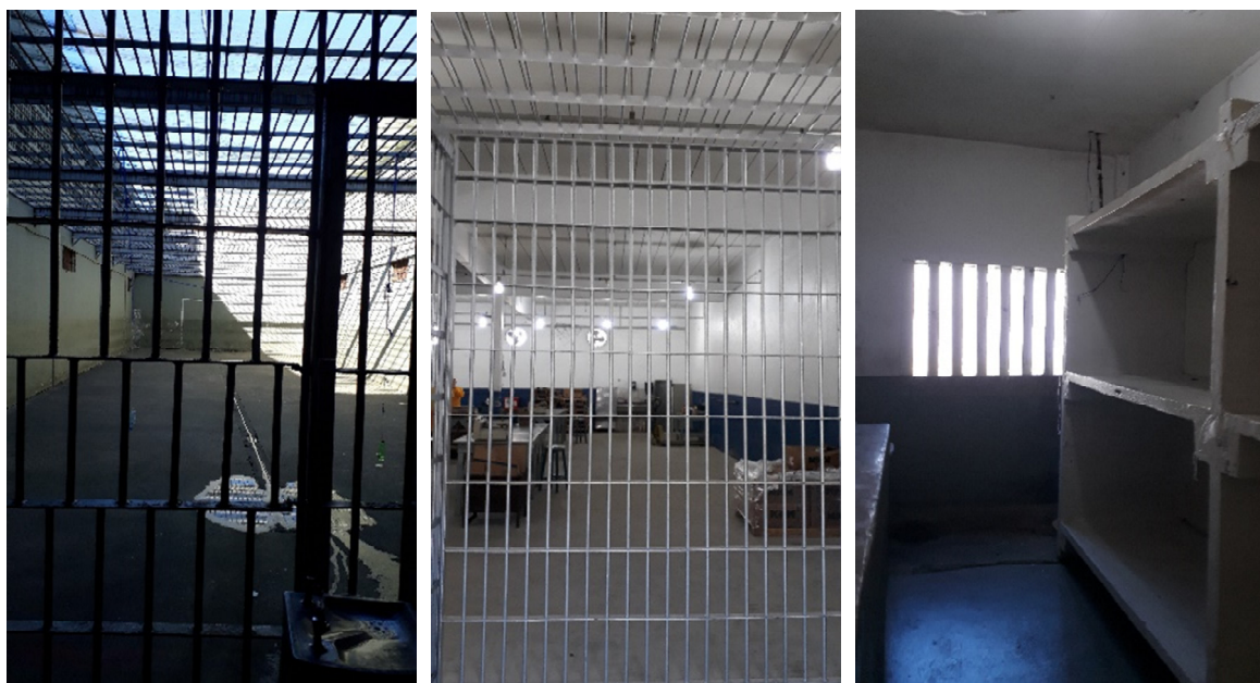
Figuras 119, 120 e 121: Imagens Internas da Penitenciária Industrial de Joinville. Pátio de um dos pavilhões (esq.), ampla oficina de trabalho (centro) e cela com capacidade para 06 presos (dir.) (Fonte: acervo do autor).
