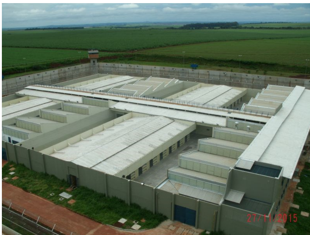
Figura 136: Imagem aérea da Penitenciária Compacta de Florínea/SP (2016), com capacidade para 847 presos em regime fechado, concebida a partir da compactação de uma variação do modelo poste telegráfico. (Fonte: www.abordagemnoticias.com/noticia/4636/detentos-brigam-no-presidio-de-florinea-e-um-acaba-morto , acesso em 13/06/2019, às 10:42h).
