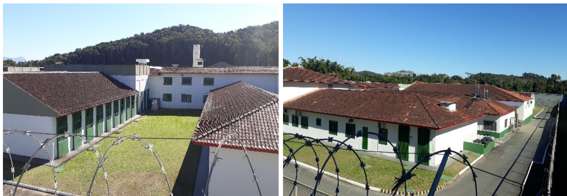
Figuras 117 e 118: Imagens dos pavilhões de celas térreas acoplados ao eixo de circulação central da Penitenciária Industrial de Joinville (Fonte: acervo do autor).
