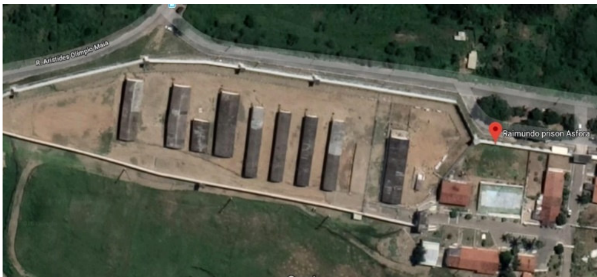
Figura 126: Aerofotograma da Penitenciária Regional de Campina Grande Raimundo Asfora (1990), localizada em Campina Grande/PB, conhecida como Serroteão por seu conjunto de módulos retangulares dispersos de modo a lembrar a forma de um serrote (Fonte: Google Earth, acesso em 21/04/2019, às 08:15h).
