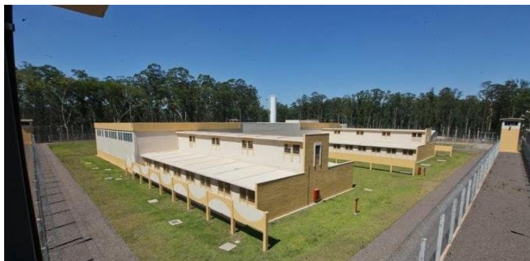
Figura 144: Imagem aérea da Unidade de Tratamento Penal de Cariri/TO (ainda em construção), com capacidade para 576 presos, construída por meio do sistema SISCOPEN e projetada a partir da compactação de uma variação do modelo poste telegráfico (Fonte: www.portal.to.gov.br/noticia/2019/4/29/unidade-de-tratamento-penal-de-cariri-esta-em-fase-final-de-construcao-/ , acesso em 28/06/2019, às 14:31h).
