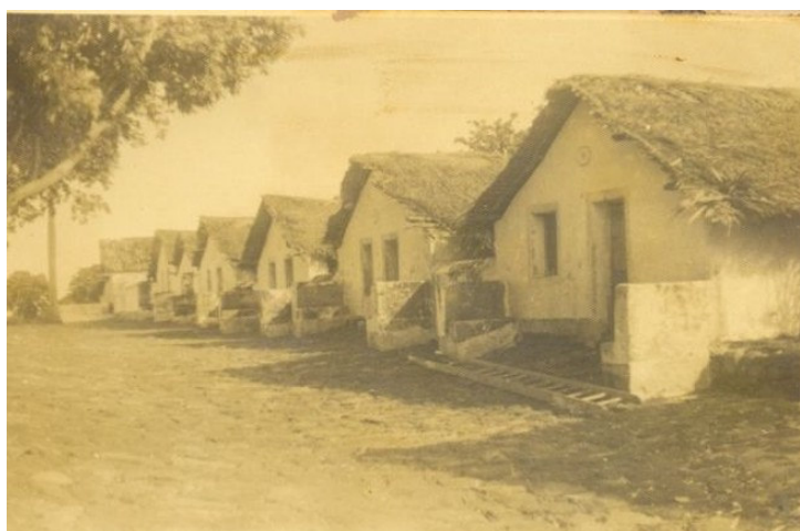
Figura 83: Imagem das casas dos sentenciados feitas com paredes de taipa e cobertas com palhoça.
