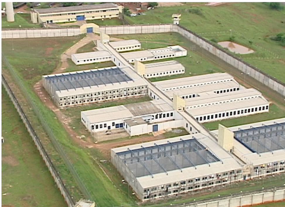
Figura 125: Imagem aérea da Penitenciária Maurício Henrique Guimarães Pereira (P2) de Presidente Venceslau/SP (1999): modelo poste telegráfico modificado, com pavilhões (ou raios) de celas dotados de 02 pavimentos e um pátio cada, acoplados ao eixo central de circulação, assim como os demais blocos de serviços e oficinas de trabalho (Fonte: Reprodução/TV Fronteira, disponível em www.msnoticiasnews.com.br , acesso em 25/04/2019, às 09:54h).
