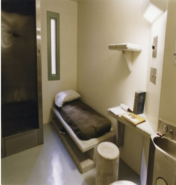
Figura 74: Cella de uma “Supermax” Prison no Condado de Fremont, Colorado – Mobiliário de concreto, pia e box para banho em aço inox (Fonte: Lizzie Himmel / Sygma via Getty Images, disponível em www.architectural-review.com , acesso em 27/08/2019, às 23:53h).
