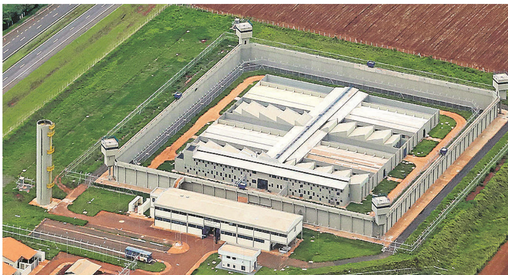
Figura 137: Imagem aérea da Penitenciária Compacta de Piracicaba/SP (2016), com capacidade para 847 presos em regime fechado, concebida a partir da compactação de uma variação do modelo poste telegráfico. (Fonte: Correio Popular, disponível em www.correio.rac.com.br , acesso em 13/06/2019, às 11:02h).
