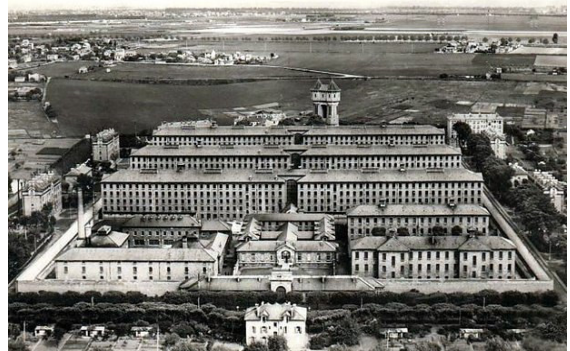
Figura 56: Vista aérea da prisão de Fresnes, 1894-1898. (Domínio Público).
