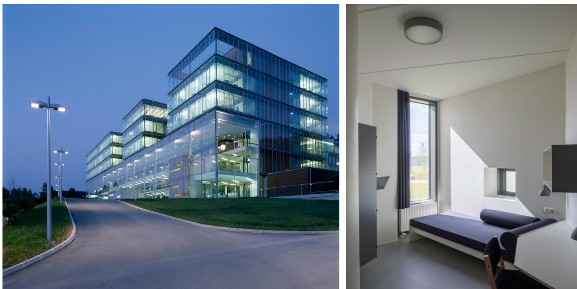
Figuras 163 e 164: Imagem externa do Centro de Justiça de Leoben, na Áustria (esq.) e interior de uma das celas da prisão de segurança máxima de Storstrøm, na Dinamarca (dir.) (Fontes: www.theplanjournal.com/article/prison-architecture-and-social-growth-prison-active-component-contemporary-city e www.urbannext.net/storstrom-prison/ , acesso em 06/01/2020, às 18:22h).
