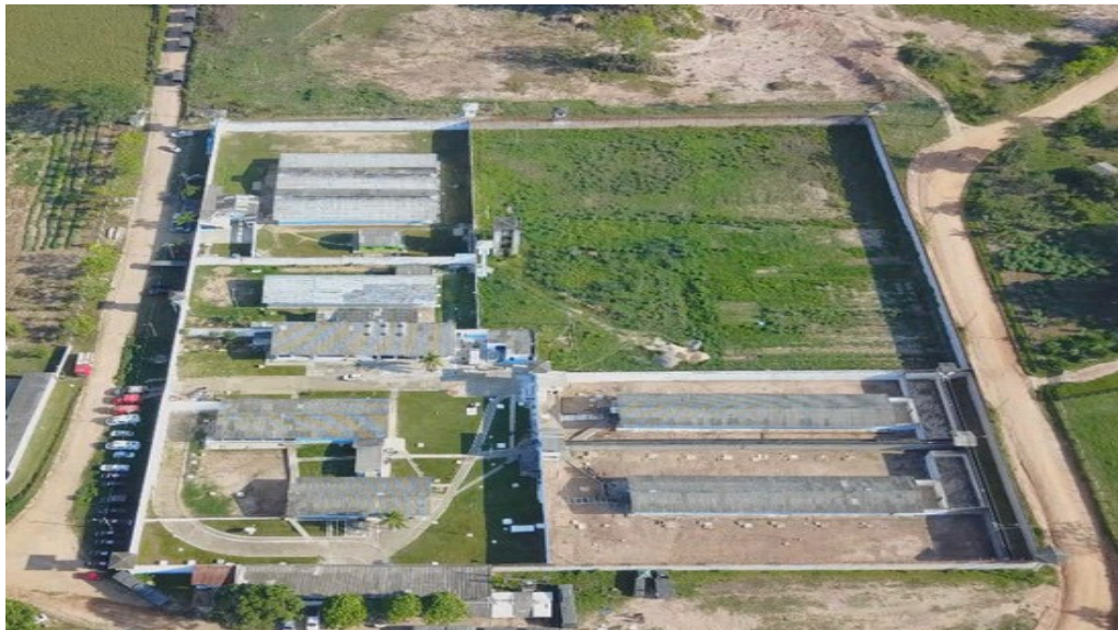
Figura 57: Imagem aérea da Penitenciária Agenor Martins de Carvalho, em Ji-Paraná/RO.(Fonte: https://www.portaljipa.com.br/noticias/policial-8/em-coletiva-exercito-divulga-resultado-da-operacao-varredura-no-presidio-agenor-martins-de-carvalho-em-ji-parana-ro--fotos-24669 acesso em 19/08/2018, às 11:42h).
