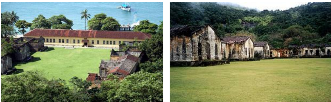
Figuras 94 e 95: Ruínas da Colônia Penal da Ilha dos Porcos (Ilha Anchieta) (Fonte: www.sap.sp.gov.br , acesso em 29/11/2018, às 15:30h).
