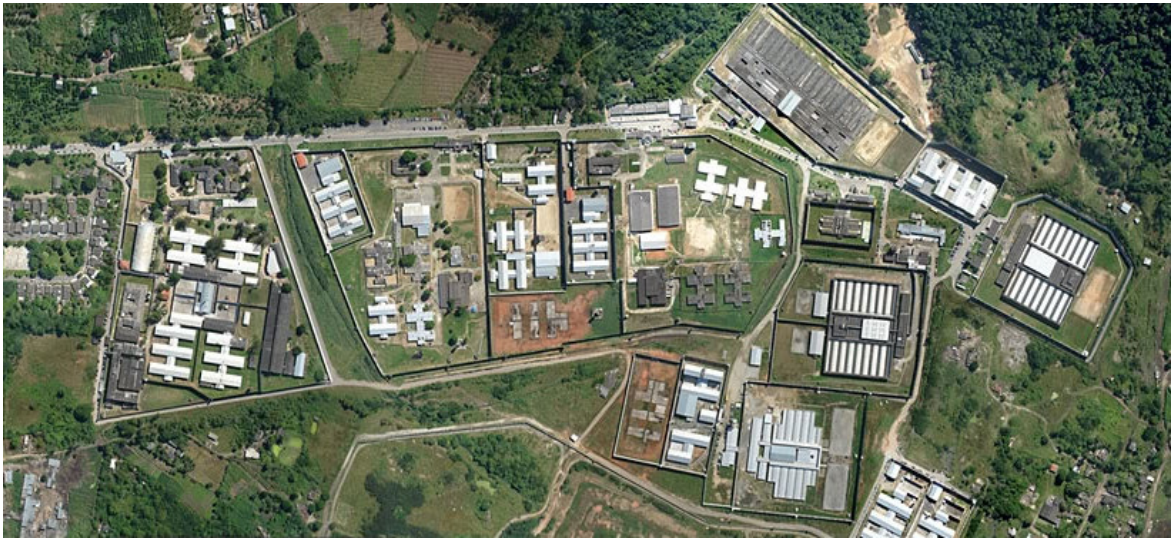
Figura 69: Vista aérea do Complexo Penitenciário de Gerico (Bangu), criado no Rio de Janeiro a partir de 1987: ampla utilização do modelo poste telegráfico (Fonte: SEAP/RJ).
