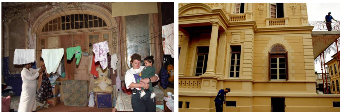
Figuras 16 e 17: Casarão Santos Dumont ocupado e restaurado
