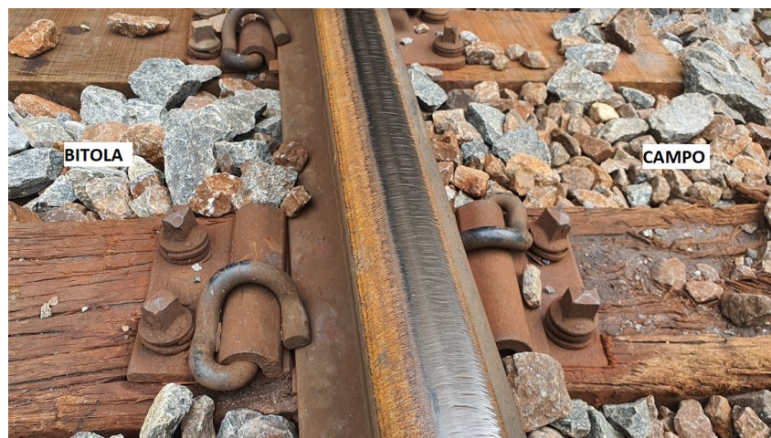
Figura 65 – Placa afundada em dormente em região de tangente.
