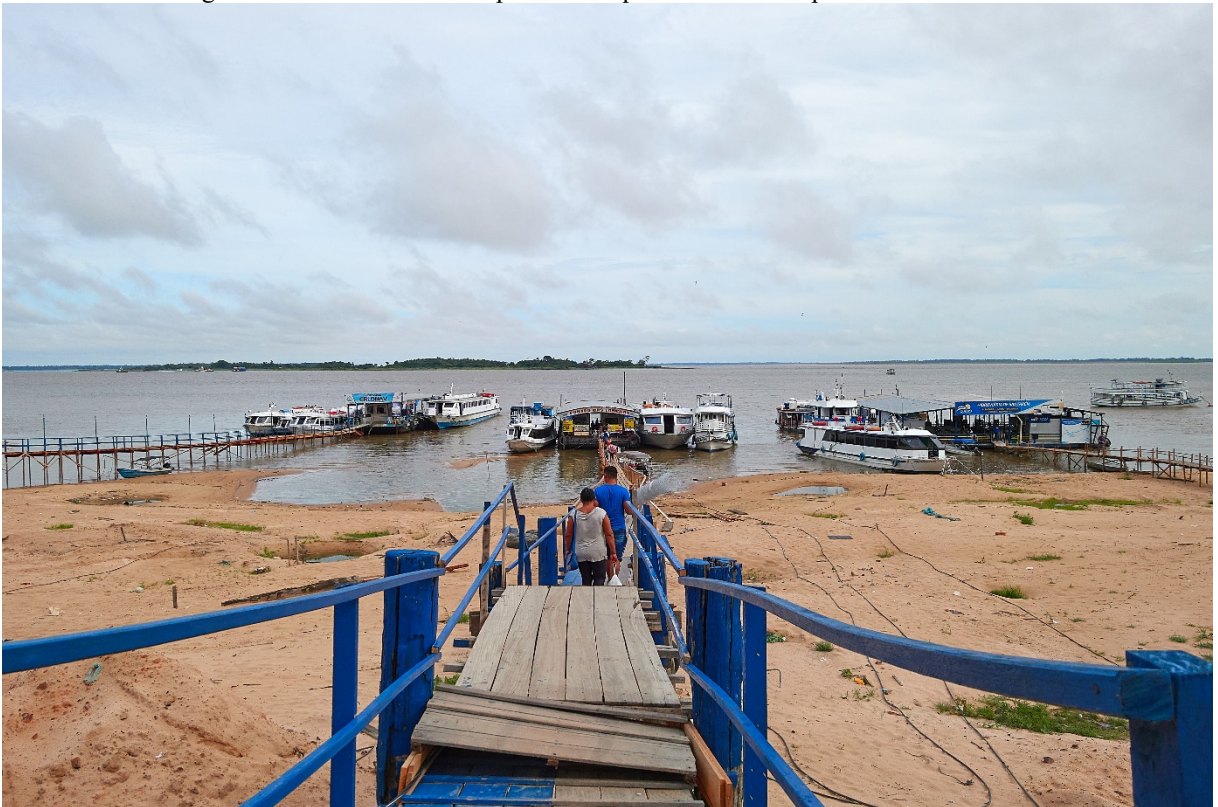
Figura 15: Cais e flutuadores para embarque em lanchas expressas em Santarém
