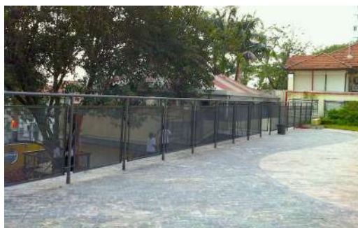
Foto 1 - Situação original do espaço sobre laje de cobertura das salas de aula
