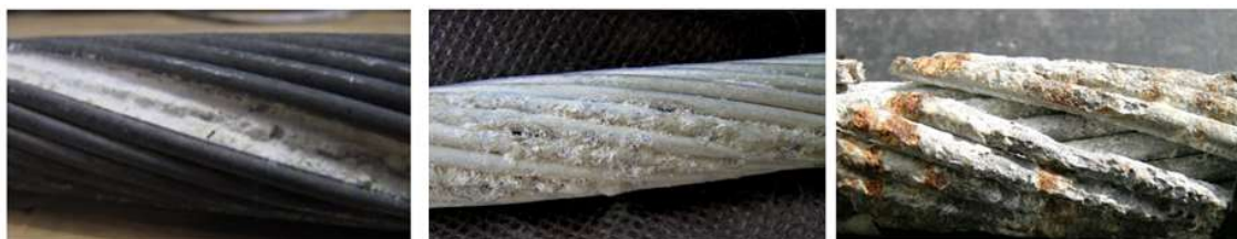
Figura 33 - Cabos com Corrosão. Fonte: [30] e [31]
