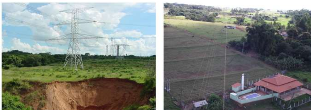
Figura 46 - Erosões e Invasões de Faixa em LT's. Fonte: [36]
