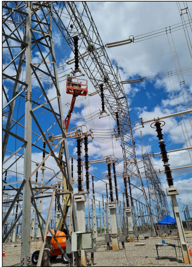
Figura 4.8 – Detalhes do processo de instalação do protótipo do sensor no arranjo das chaves seccionadoras (I).
