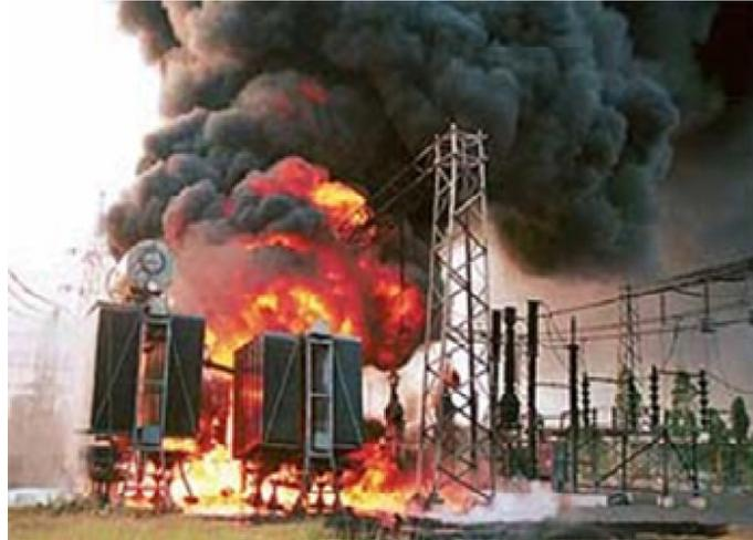
Figura 5.37: Incêndio no transformador de potência da subestação.
