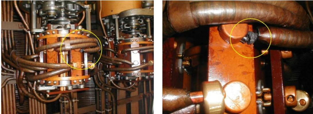
(a) Visão do comutador com a conexão carbonizada.
