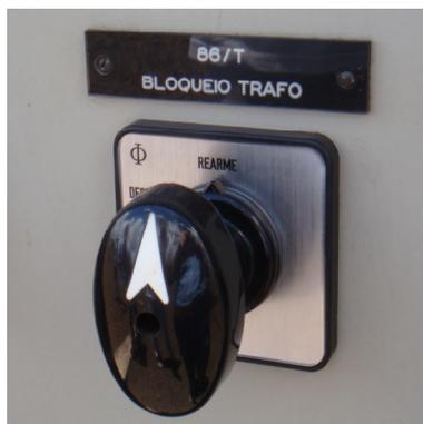
Figura 8.2: Relé auxiliar de bloqueio do transformador - relé 86T.
