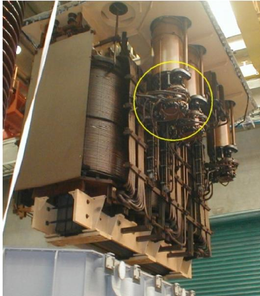
Figura 5.35: Aspecto geral da parte ativa lado alta tensão - em detalhe o comutador.
