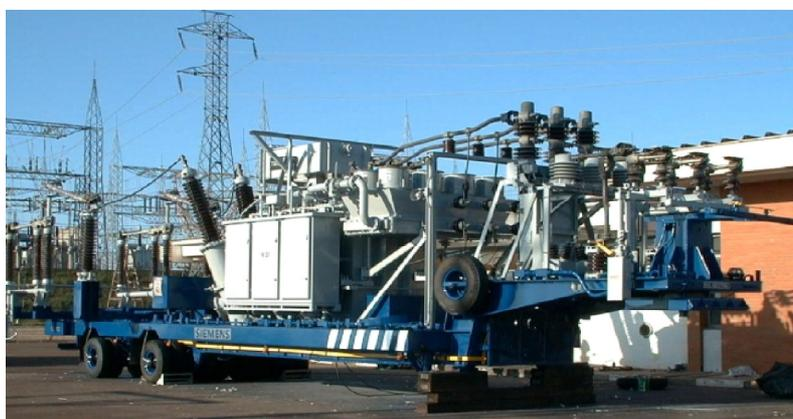
Figura 5.29: Subestação móvel de 20MVA - 138-13,8kV.
