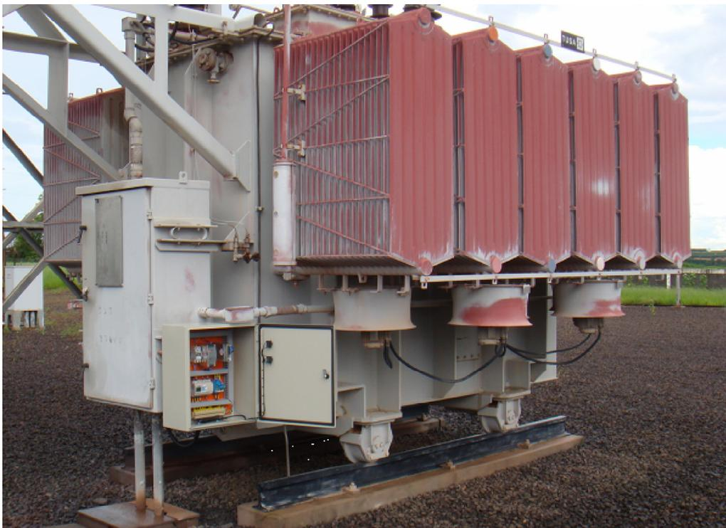
Figura 8.30: Painel de controle instalado no transformador 25MVA/138kV da SE Itápolis.
