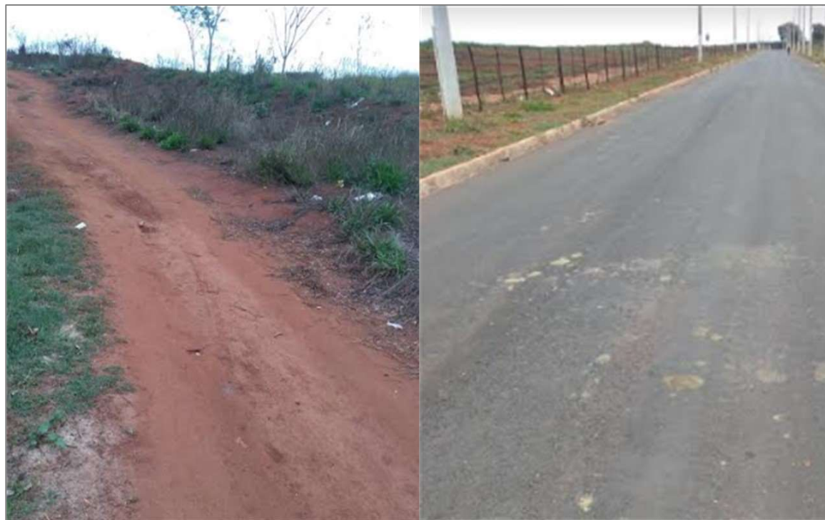
Figura 5.18: Condições atuais da Rua Dois e da Av. Luís Francischini em Ibitinga-SP.
