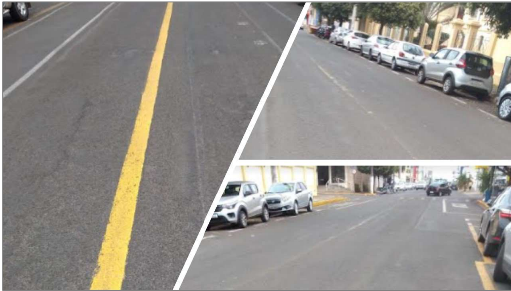
Figura 5.16: Centerline na Av. Dom Pedro II em Ibitinga-SP.
