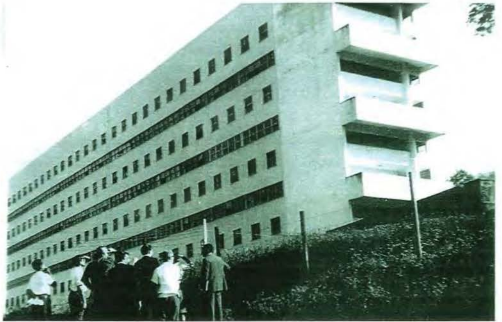
Conjunto Residencial Vila Isabel, 1965 (FUNDAÇÃO LEAO XIII)
