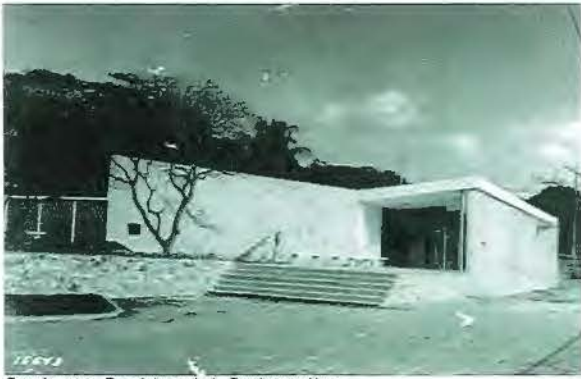
Conjunto Residencial Pedregulho: centro de saúde, 12.7.1950 (AGCRJ)
