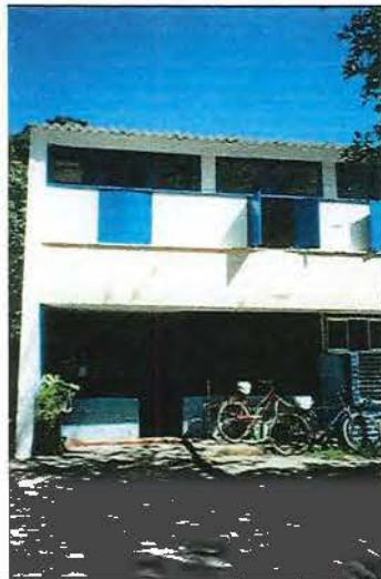
Conjunto Residencial Paquetá: bloco residencial (foto: F. Brito, 2001)
