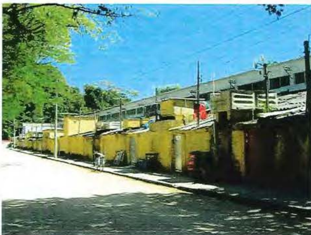
Fachada posterior do bloco residencial (foto: F. Brito, 2001)
