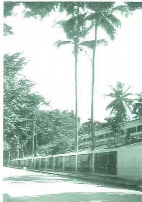
Bloco residencial, fachada posterior (MINDLIN, 1999:153)
