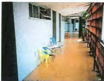
Conjunto Residencial Pedregulho: bloco A, fachadas e corredor de acesso aos apartamentos (foto: F. Brito, 2000)
