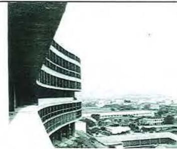
Conjunto Residencial Pedregulho: Bloco A em construção, anos 50 (AGCRJ)
