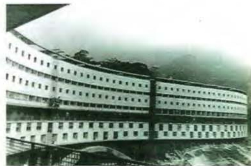
Bloco A em construção (APCP)
