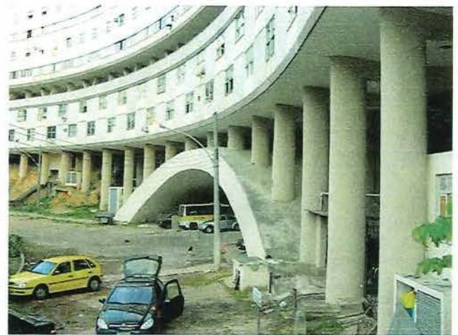
Bloco A: arco estrutural (foto: F. Brito, 2003)
