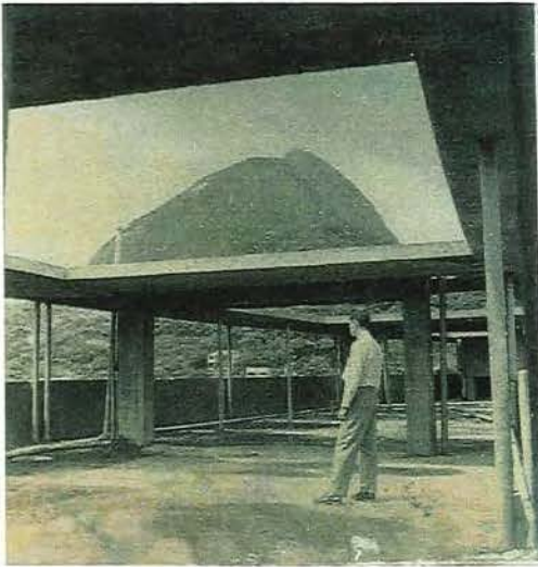
Cobertura do conjunto, onde localiza-se a lavanderia coletiva (APCP)
