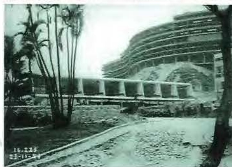
Conjunto Residencial Pedregulho em construção, com a escola recém-inaugurada, 23.11.1951 (AGCRJ)
