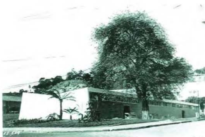
Lavanderia, fachadas lateral e posterior, 12.7.1950 (AGCRJ)
