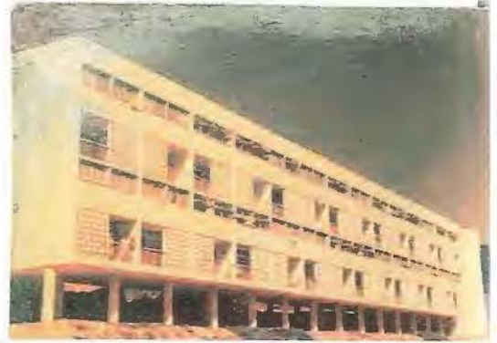
Conjunto Residencial Pedregulho: bloco B1 (APCP)
