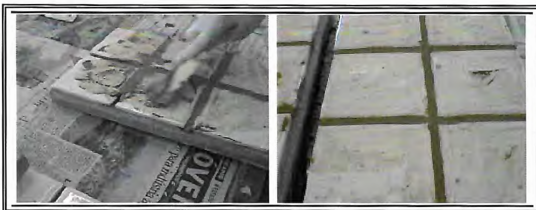
Figura 17 – Aplicação do rejunte
