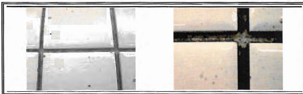
Figura 15 - Juntas de assentamento limpas com escova de cerdas plásticas
