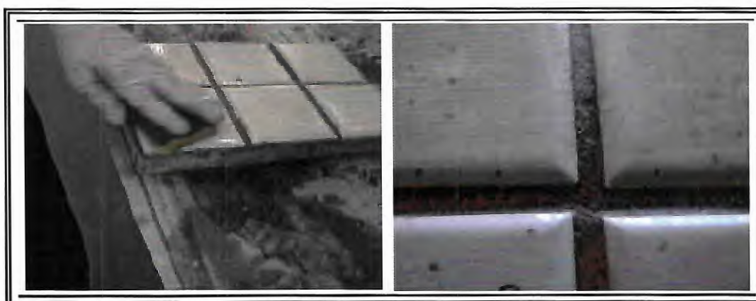
Figura 19 – Limpeza inicial das placas
