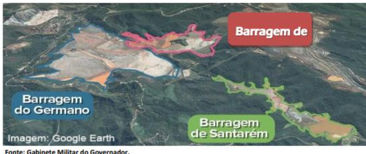
Figura 1: Localização das três barragens de contenção do município de Mariana construídas pela mineradora SAMARCO.
