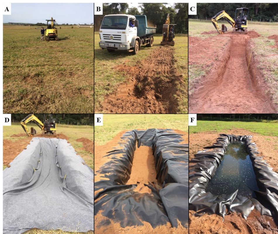
Figura 11 - Etapas de construção dos mesocosmos na área experimental. A) Reconhecimento da área; B e C) Escavação do terreno com trator; D) Impermeabilização com manta geotêxtil (GF07), seguida de geomembrana lisa de polietileno de alta densidade (PEAD) com espessura de 0,5 mm; E) Deposição de 10 cm de solo local como sedimento; e F) Preenchimento dos mesocosmos com água de poço artesiano local.
