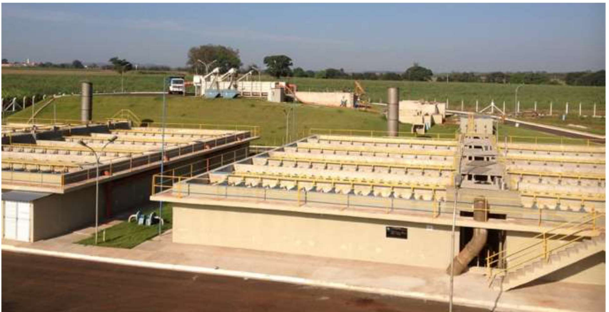
Figura 25 - Vista dos Reatores UASB 1 e 2 da ETE Laranja Azeda com o tratamento preliminar ao fundo.
