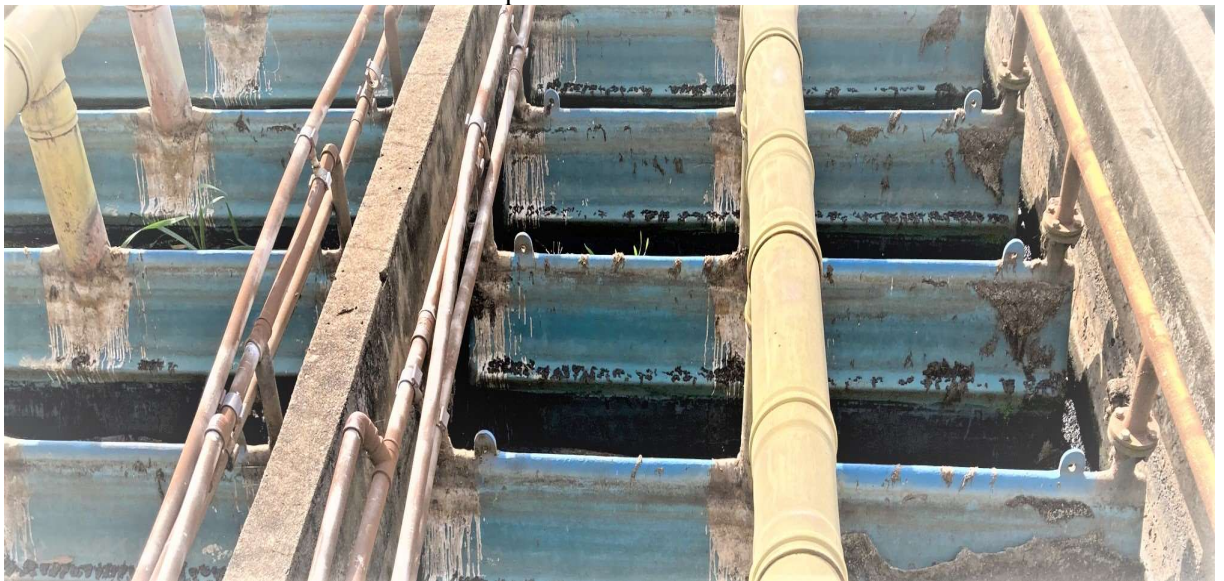
Figura 23 – Visão dos separadores trifásicos do reator anaeróbio da ETE Laranja Azeda – Vista superior.
