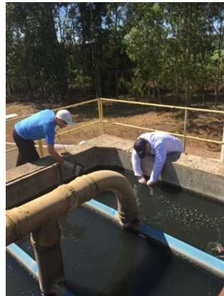
Figura 29- Coleta: Frasco cheio 10 cm abaixo do nível d'água
