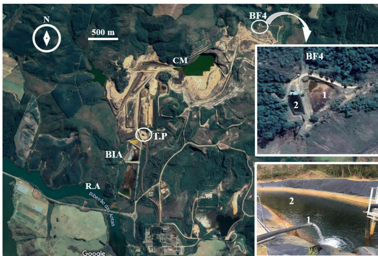
Figura 5. 2- Imagens de satélite destacando as principais lagoas de DAM da INB (Google). Onde: R.A- Ribeirão das Antas; BIA- Bacia Ivan Antunes (BF8); T.P- Planta de tratamento físico-químico da DAM; BF4- Bacia Nestor Figueiredo (BNF) 1-lagoa velha e 2- lagoa nova com manta impermeabilizante.
