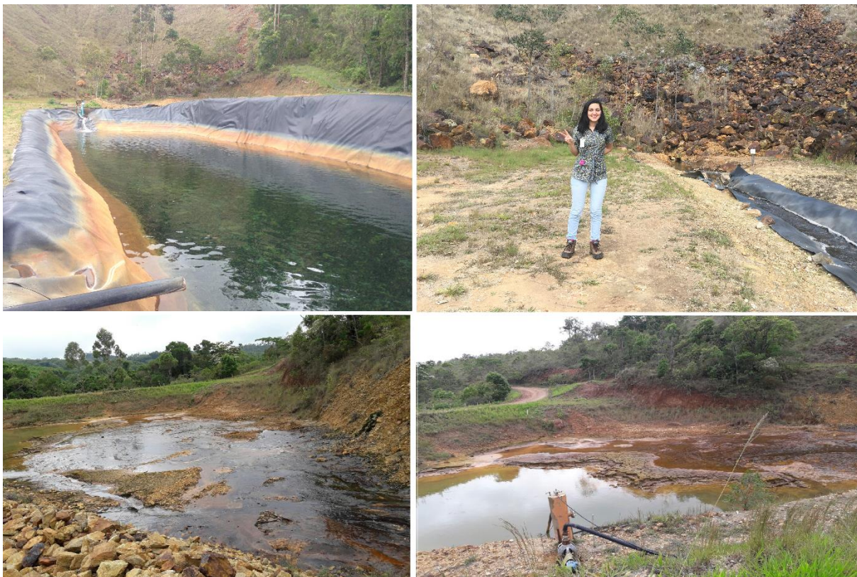
Figura 6. 2- Local de coleta da DAM para o preparo da alimentação do reator anaeróbico. A imagem apresenta as duas lagoas BF4, a lagoa nova revestida com manta impermeabilizante e a lagoa velha onde não há impermeabilização.
