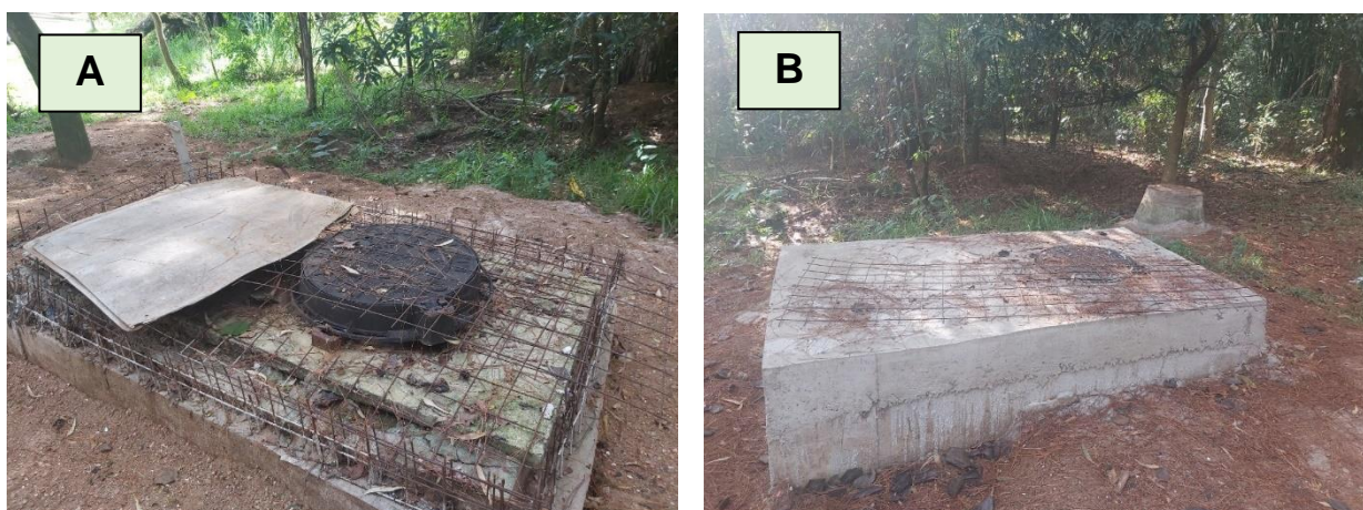
Figura 18 – PV dentro da área da captação do Espraiado A) antes da finalização das obras pelo SAAE B) após a finalização das obras pelo SAAE.
