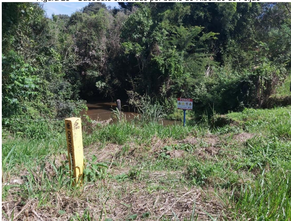
Figura 23 - Gasoduto enterrado por baixo do Ribeirão do Feijão
