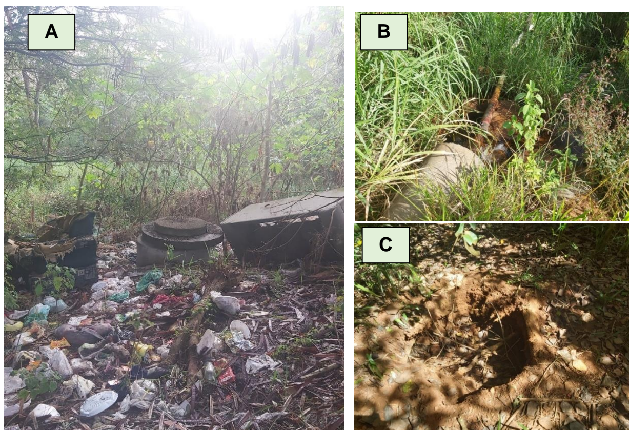
Figura 14 – A) Poço de visita do sistema de esgotamento sanitário e acúmulo de resíduos próximo ao Córrego Ponte de Tábua B) Captação de água particular no Córrego São Rafael C) Ponto onde localizava-se o PV próximo ao Córrego do Belvedere.
