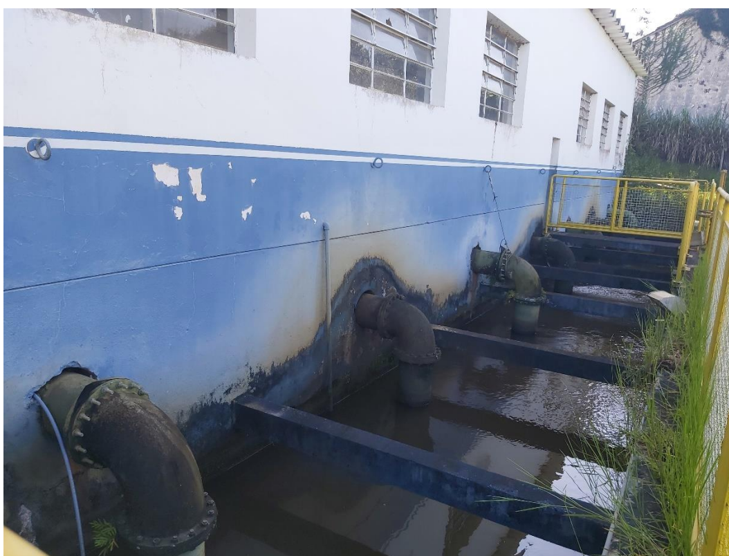
Figura 6 – Poço de sucção da captação do Ribeirão do Feijão
