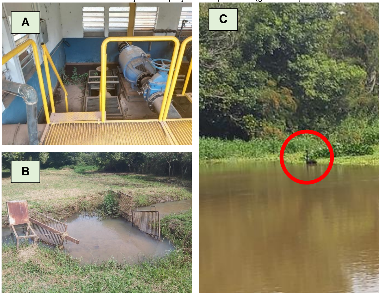
Figura 17 – A) Presença de vegetação na casa de Bombas da captação do Espraiado B) Gradeamento à entrada da Captação do Espraiado – Córrego do Espraiado C) Presença de animais no reservatório de acumulação da captação do Espraiado – (grifo nosso).
