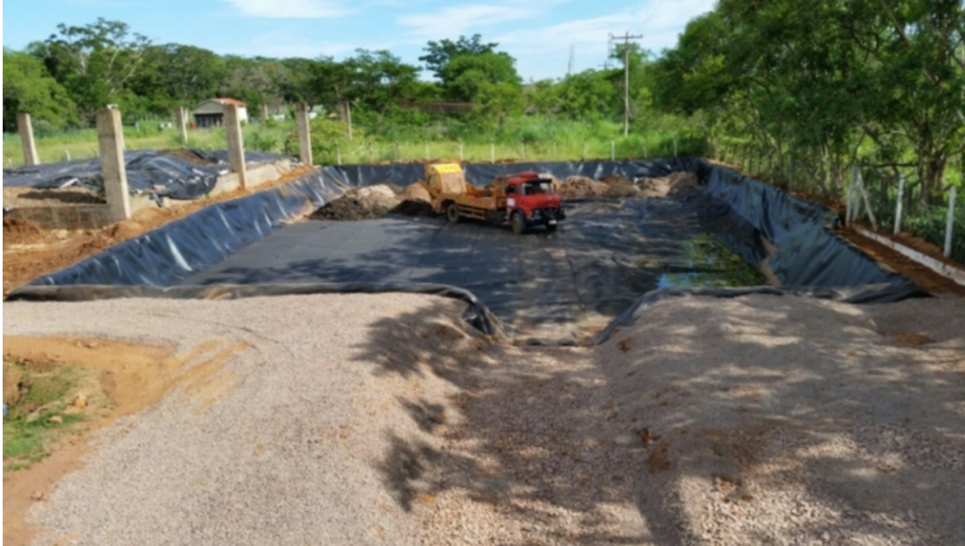
Figura 22 – Construção de uma lagoa de lodo com revestimento de geotêxtil
