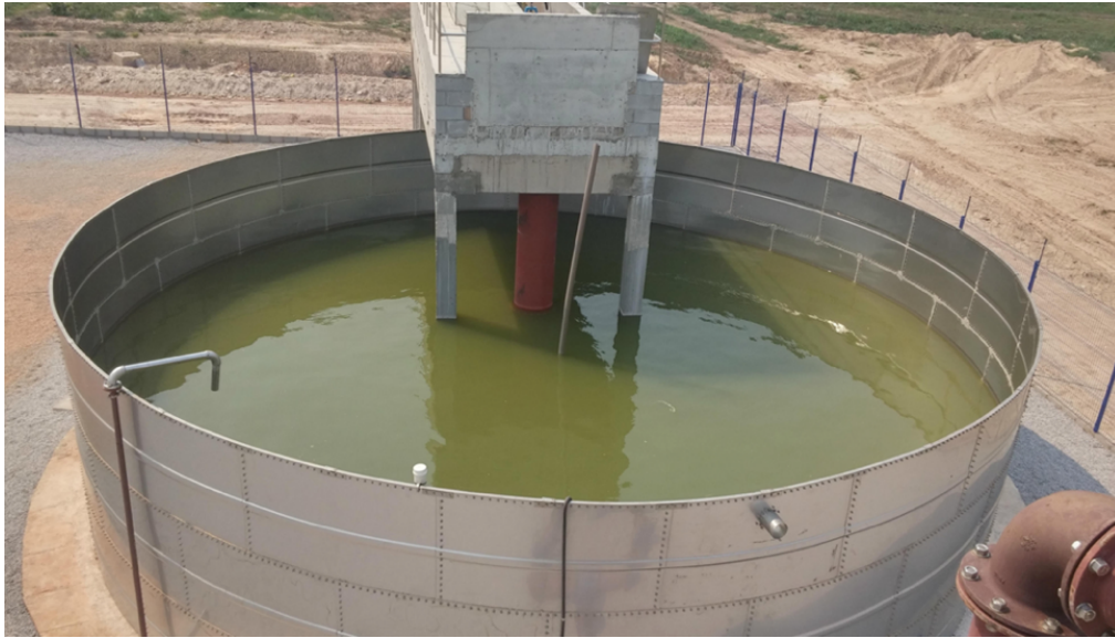
Figura 13 – Vista superior de um tanque de regularização de vazão em chapa de aço
