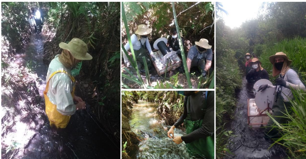
Figura 11 - Instalação da fibra ótica no leito do Ribeirão da Onça
