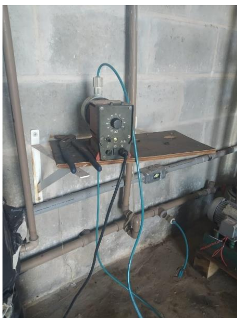
Figura A1: Bomba de diafragma para alimentação do reator.
