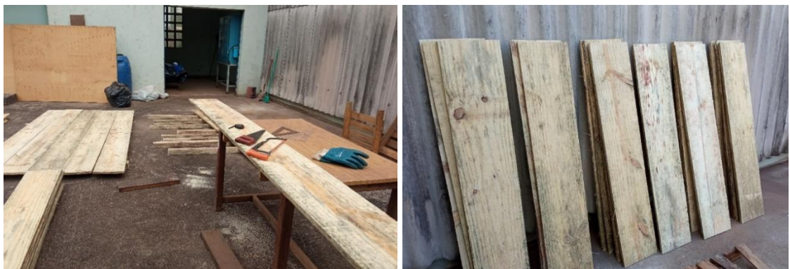
Figura 4 – Construção das baias de compostagem.
