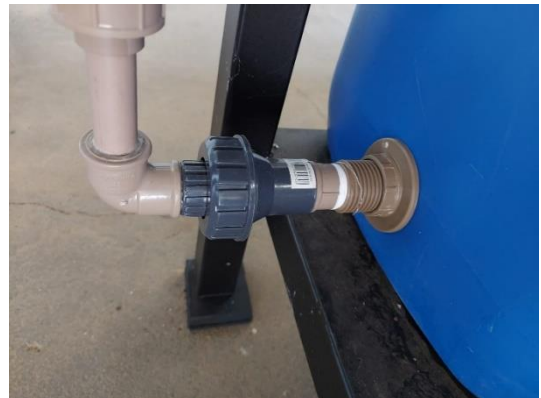
Figura 5.2. Detalhe das válvulas de retenção localizadas na saída do reservatório de água bruta (a) e na entrada do reservatório de água ozonizada (b)
