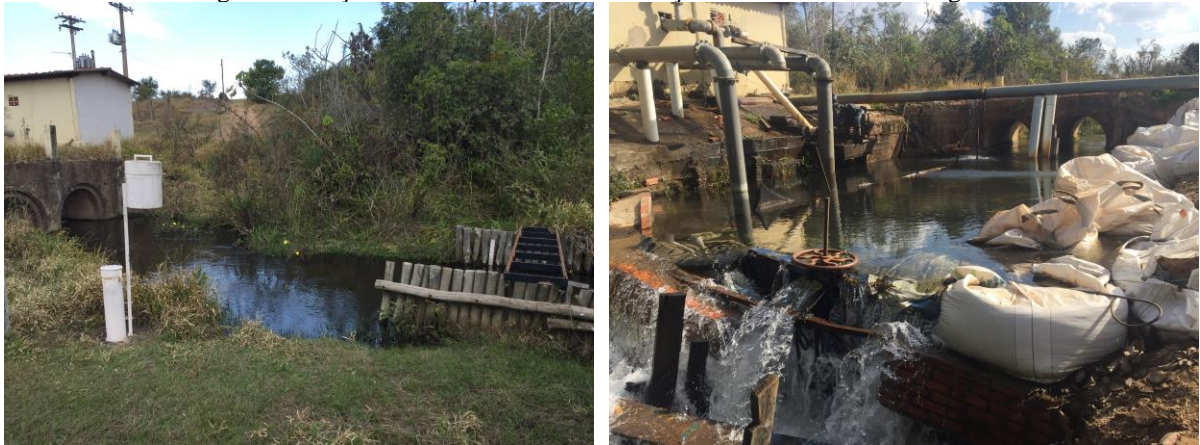
(a) Seção onde nível e vazão são medidos (montante). (b) Local onde o curso d'água é represado (jusante). Fonte: Autor.
