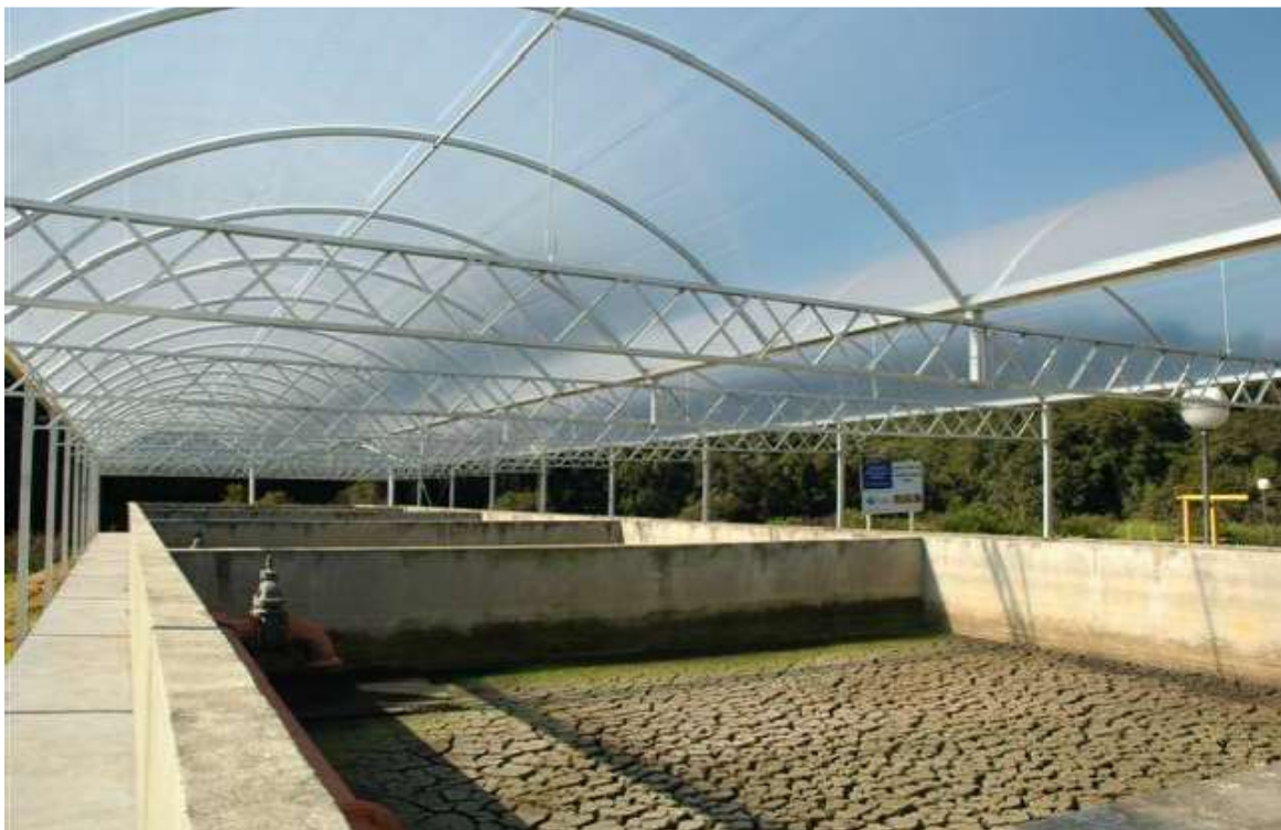
Figura 2: Técnica de desidratação por leito de secagem coberto, em ETE.
