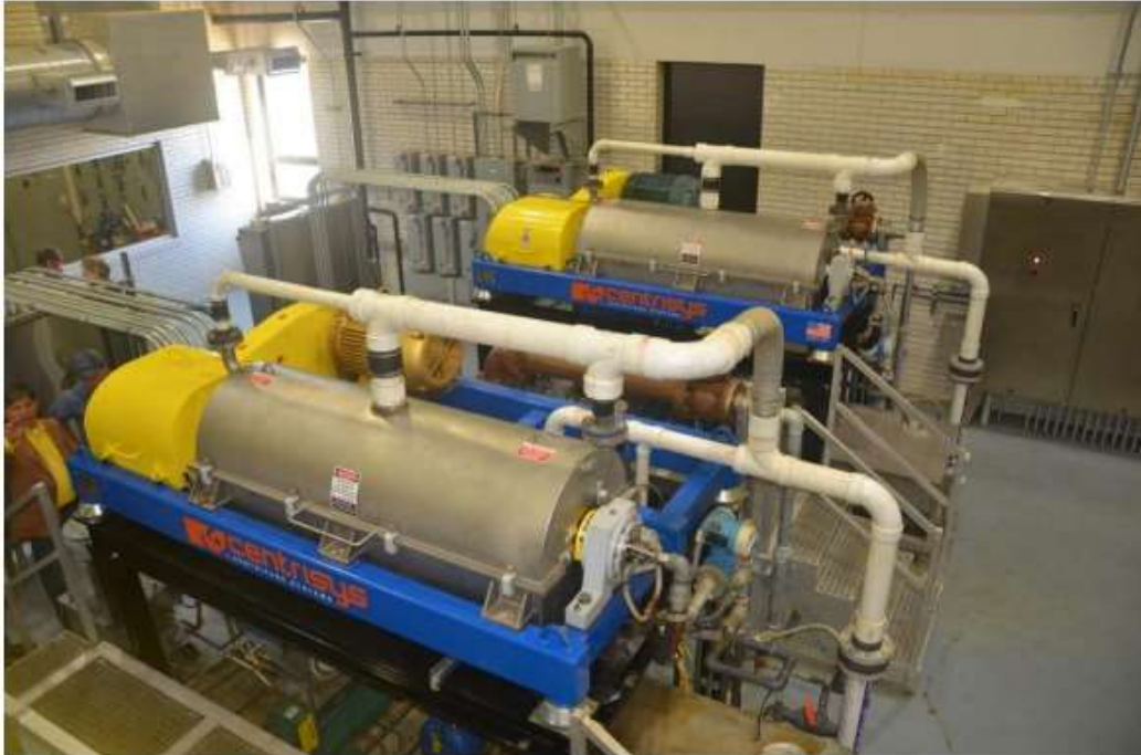
Figura 3: Modelo de centrífuga de desidratação de lodo.
