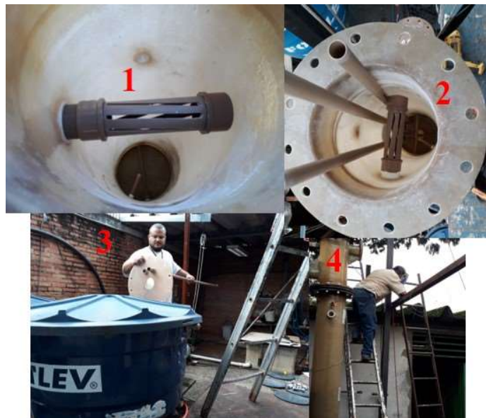
Figura 12 – Montagem do RAANA piloto: 1- Sistema de coleta de efluente tratado, 2-Vista superior da zona anóxica sem tampa e sem meios suporte, 3- Montagem do tubo sonda no separador de fases modificado e 4- Início da montagem do mezanino.
