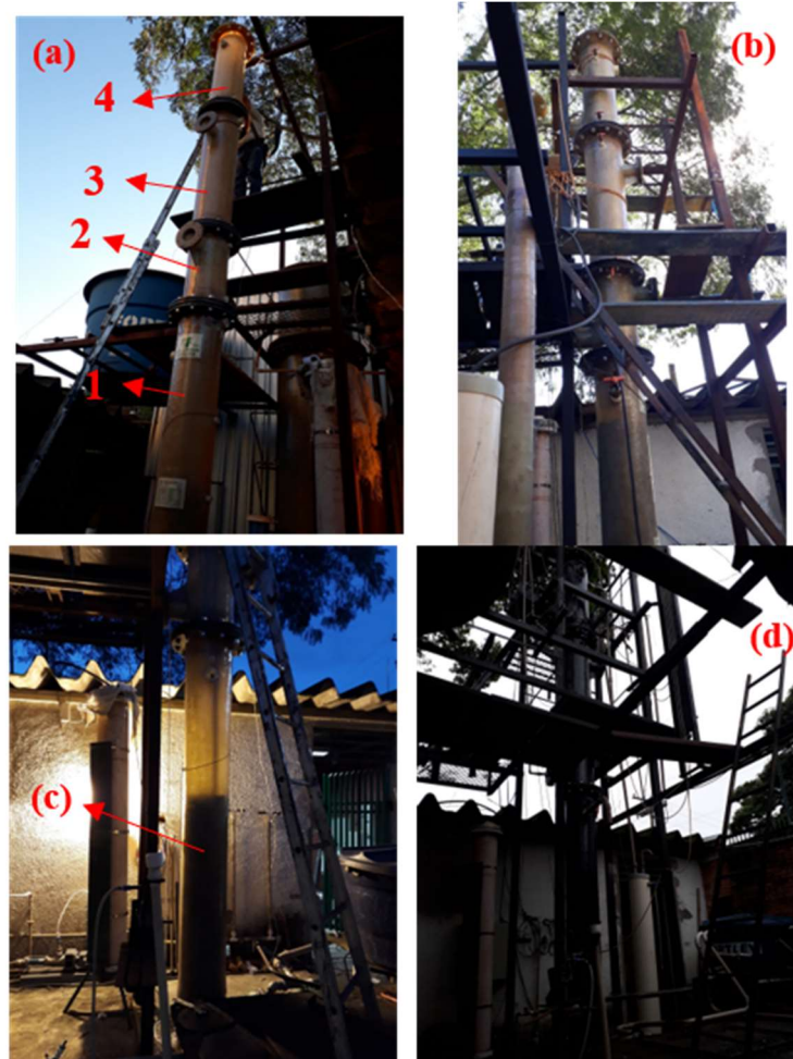
Figura 19 – Montagem do RAANA piloto: (a) Início da montagem: 1– Zona anaeróbia, 2– Zona aeróbia, 3– Zona nitrificante e 4- Zona anóxica; (b) Reator montado no mezanino; (c) Destaque para o meio suporte Biobob® na zona anaeróbia e (d) Reator pintado na cor preta para evitar crescimento de algas.
