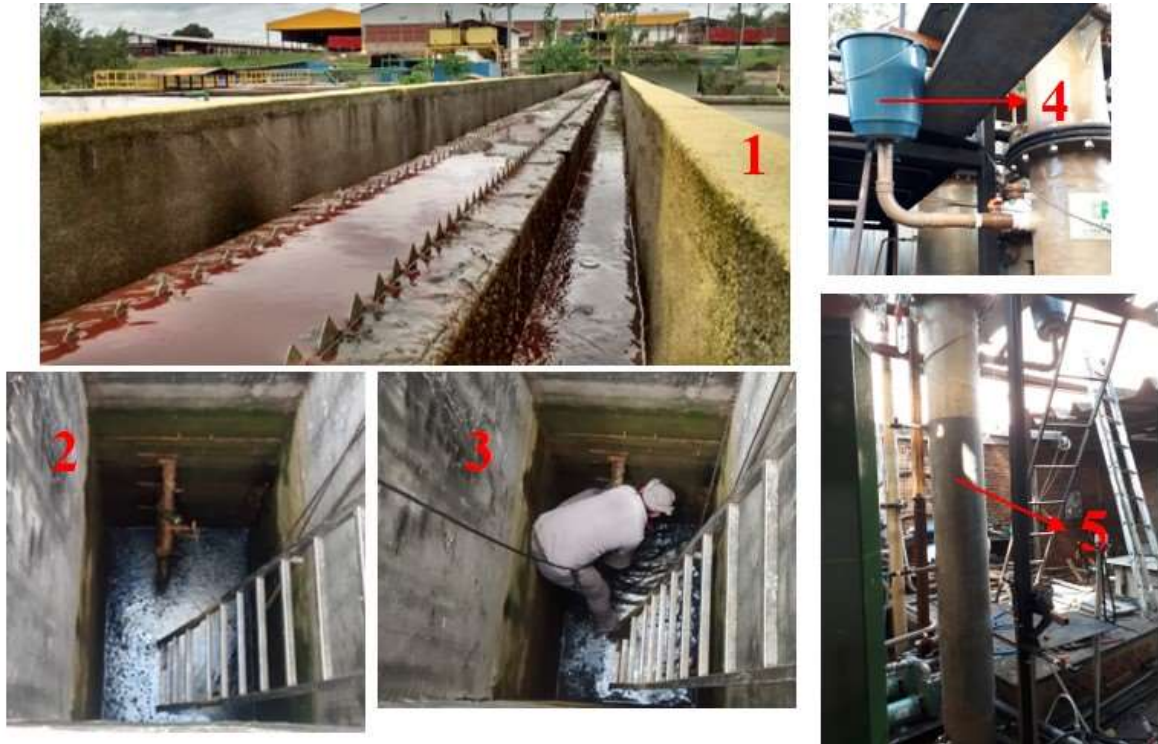
Figura 20 – (1) Distribuidor da água residuária bruta, (2) Amostradores de lodo do reator UASB do frigorífico Ideal, (3) Coleta de lodo anaeróbico, (4) Ponto de lançamento de lodo no RAANA piloto e (5) Lodo na zona anaeróbia do RAANA piloto.
