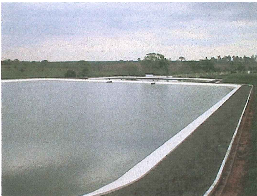
FIGURA 16 – Irapuã: vista das lagoas facultativa secundária e anaeróbia ao fundo
