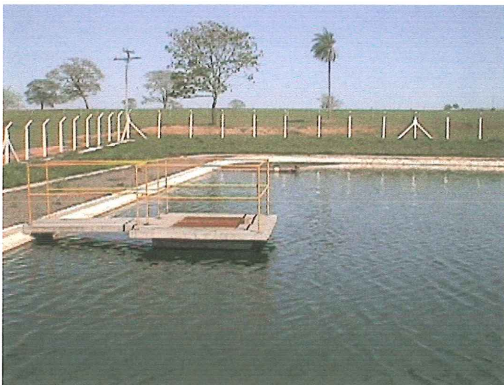
FIGURA 11 – Zacarias: vista da saída do sistema de tratamento
