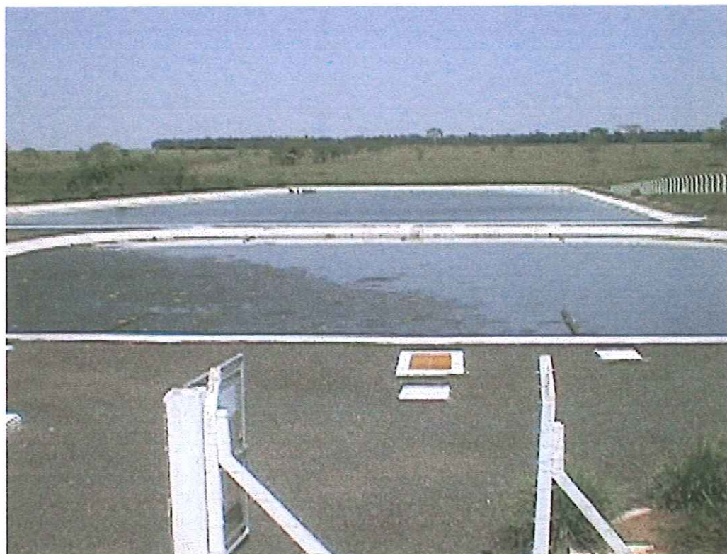
FIGURA 18 – Adolfo: vista das lagoas anaeróbia e facultativa secundária ao fundo
