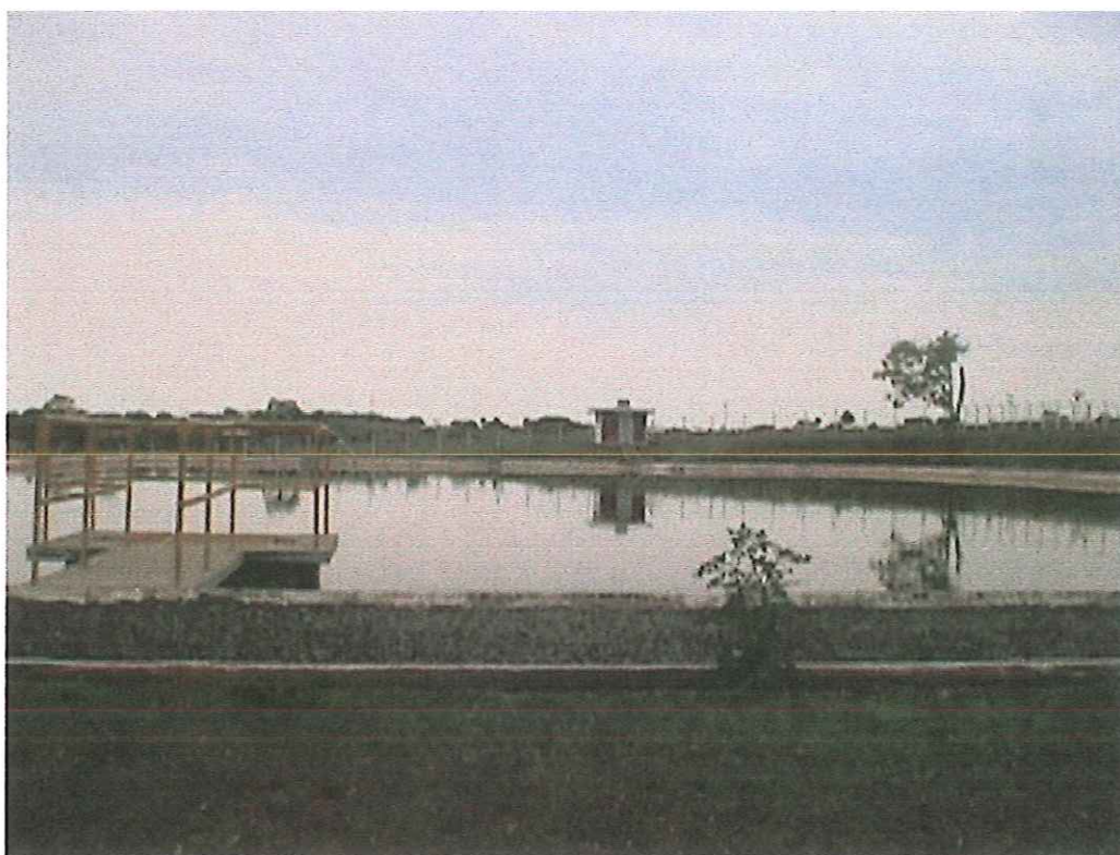
FIGURA 7 – Lourdes: vista da saída do sistema de tratamento
