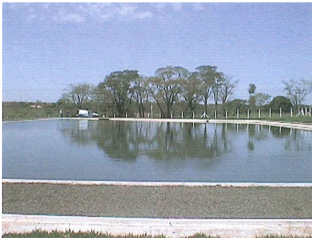
FIGURA 10 – Zacarias: vista geral da lagoa facultativa primária
