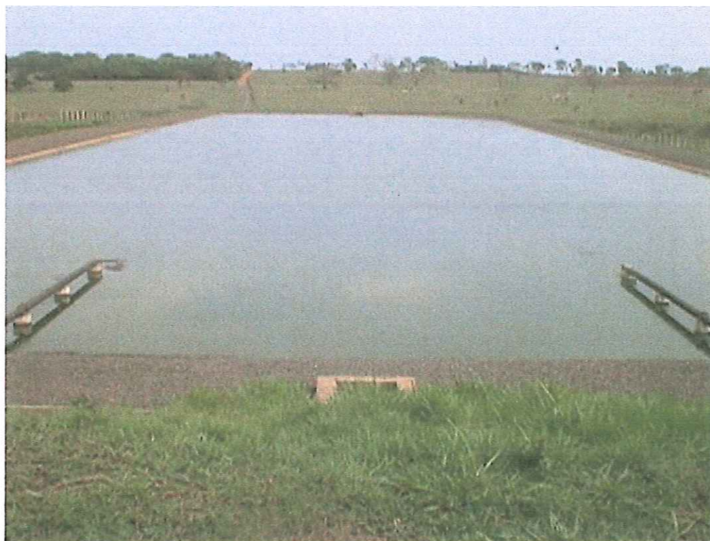
FIGURA 8 – Planalto: vista da entrada da lagoa facultativa primária
