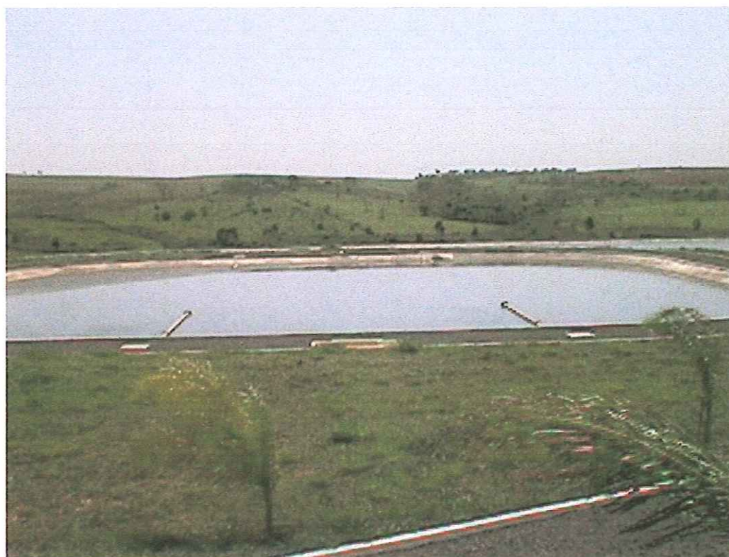
FIGURA 14 – Pongá: vista da lagoa anaeróbia
