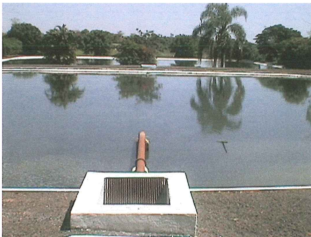
FIGURA 12 – Alto Alegre: vista geral das lagoas anaeróbia e facultativa secundária
