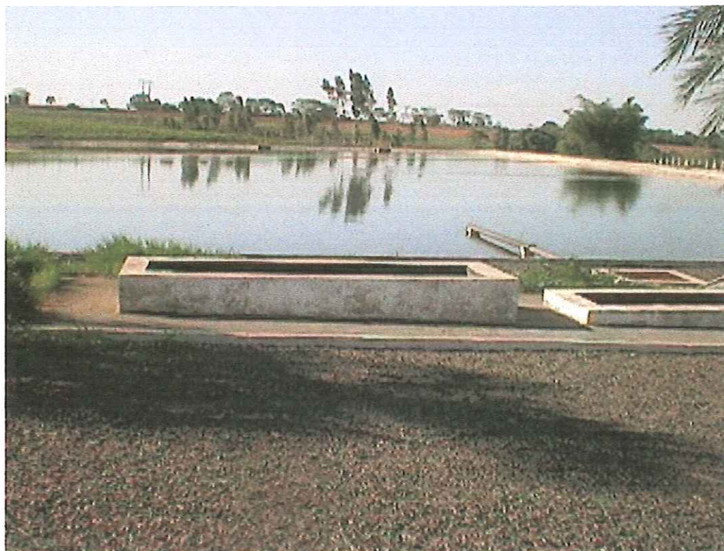
FIGURA 4 – Coroados: vista do tratamento preliminar e lagoa facultativa primária
