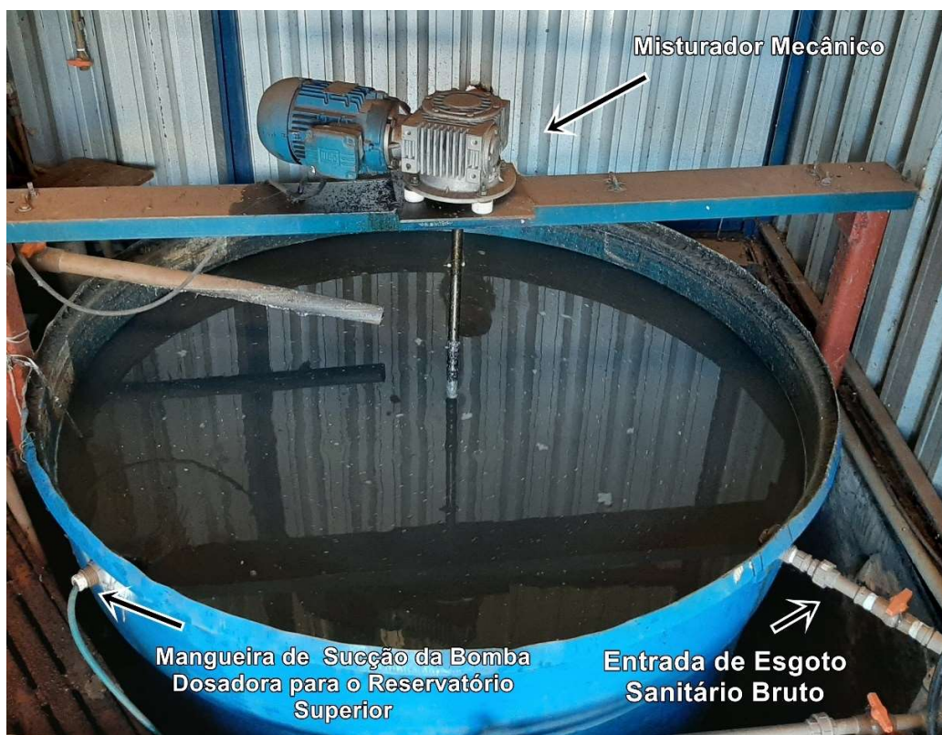
Figura 06 – Reservatório inferior utilizado para armazenamento de esgoto sanitário bruto
