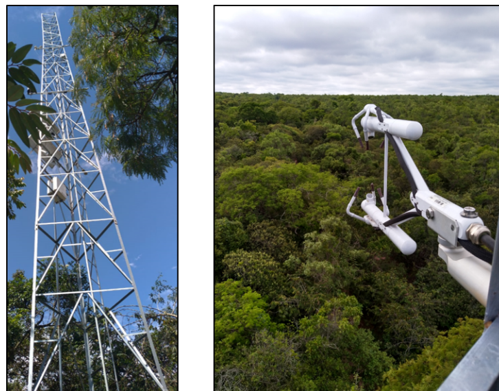
Figura 8 – Torre de monitoramento IAB3
