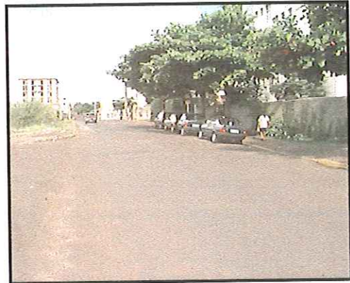
Figura 23 - Vista da Alameda dos Crisântemos (segmento 10). São Carlos, SP. Setembro 1997.
