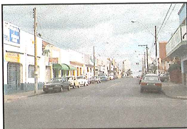
Figura 14 - Vista da Av. São Carlos (segmento 1). São Carlos, SP. Setembro 1997.
