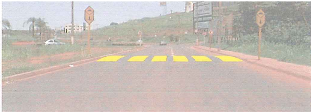
FIGURA 46: Imagem editada da lombada com o sinal implantado em São Carlos
