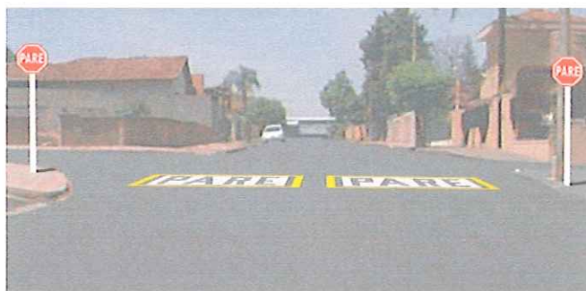
FIGURA 57: Sinalização horizontal implantada em Araraquara Fonte: imagem editada pelo autor
