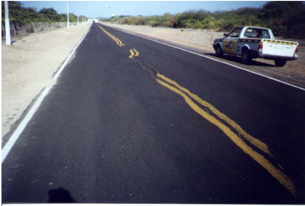
Figura 3.5: Recapeamento de AAUF defeituoso
