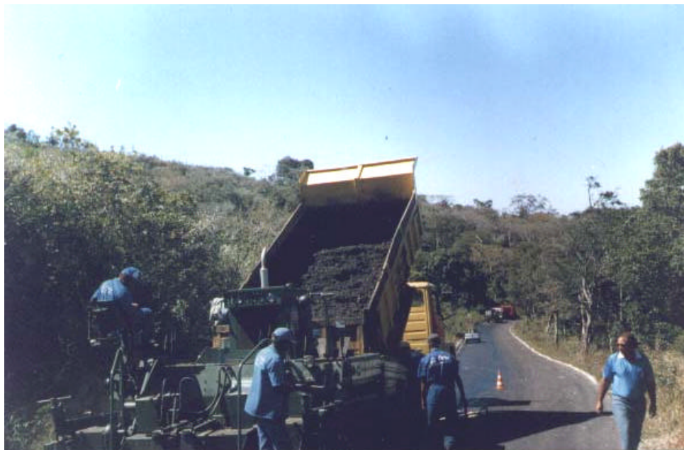
Figura 3.3: Espalhamento de AAUF para restauração de um trecho
