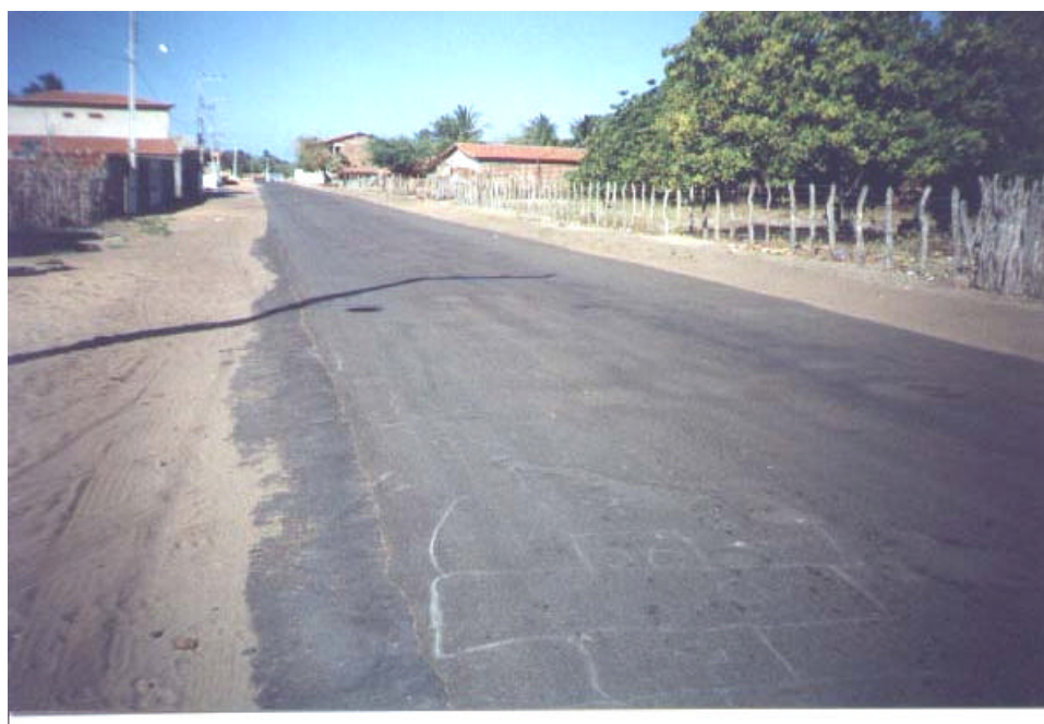
Figura 3.4: Revestimento de areia-asfalto em bom estado
