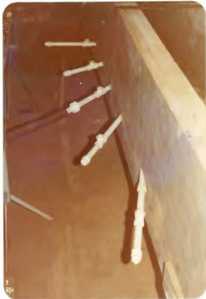
FIG. 3.10 - Tubos de lançamento
