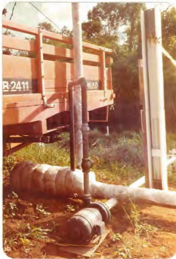
FIG. 3.17 - Bomba d'água e trocador de calor
