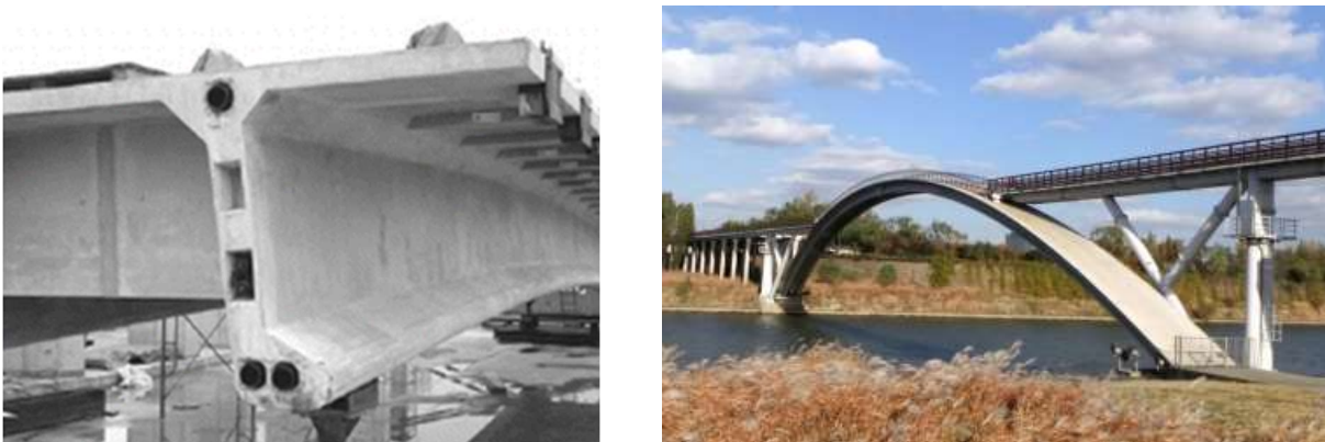
Figura 2.18 Passarela de pedestres Seonyu, Coreia do Sul
