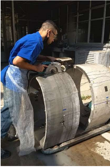
Figura 4.44 Corte e verificação da posição de armaduras nas seções das galerias
