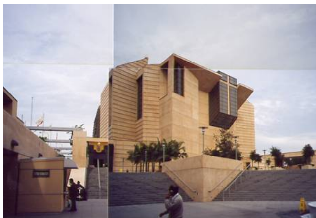
Figura 7. Catedral de Los Angeles. Fonte:Concreto Colloquia, São Carlos:USP, 2003.1 CD-ROM.
