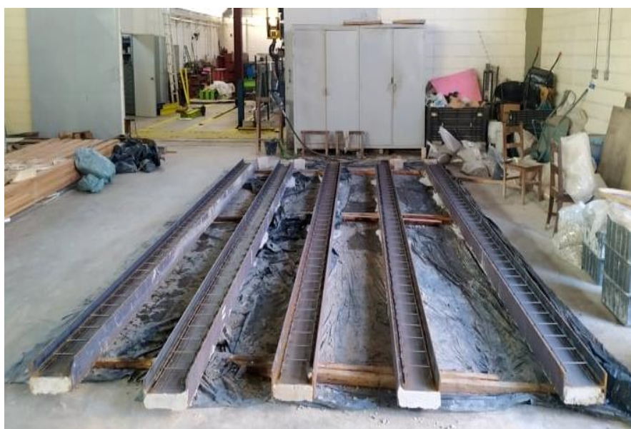
Figura 6.2 – Posicionamento das armaduras no perfil e aço
