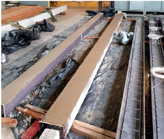
c) Vigas com superfície acabada
