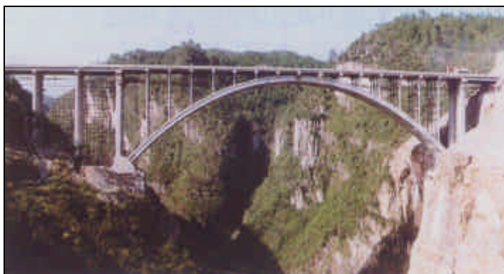
FIGURA 2.1 - EXEMPLO DA APLICAÇÃO DE ELEMENTOS MISTOS NO SISTEMA ESTRUTURAL DE UMA PONTE - CHINA 2
