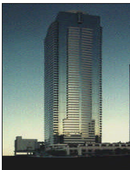
Edifício Two Union Square 5 60 pavimentos; f_{ck}=110\text{MPa} (nos pilares) localização: Washington - Estados Unidos
