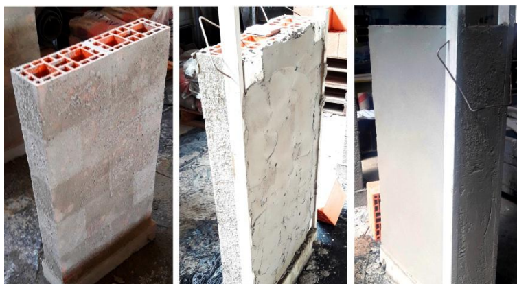
Figura 4.2 – Execução do revestimento nos elementos de alvenaria
