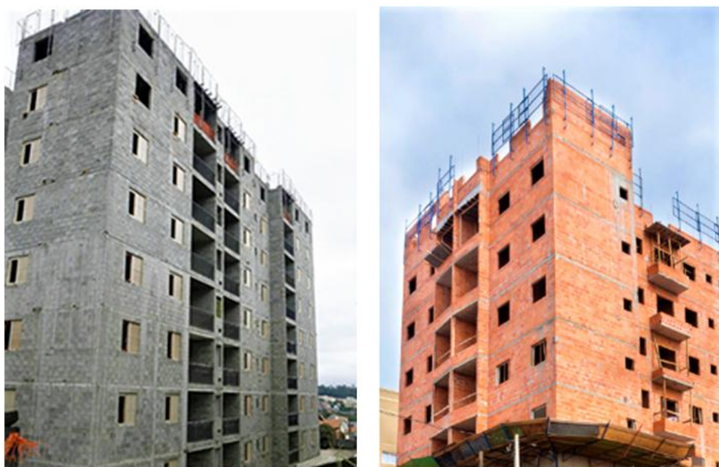
Figura 2.1 – Edifícios em alvenaria estrutural com blocos de concreto e cerâmicos
