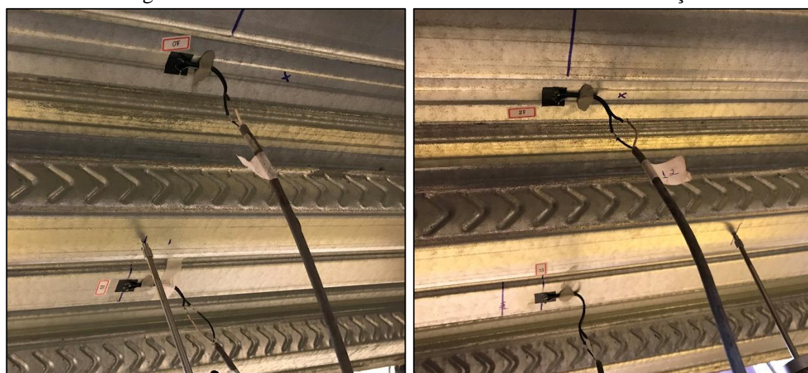
Figura B.2 – Posicionamento dos extensômetros na fôrma de aço
