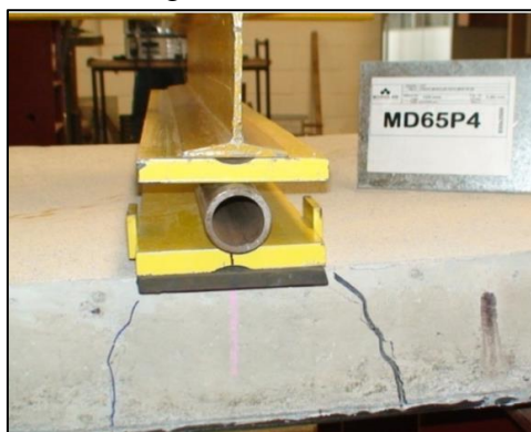
(a) Aspecto típico da fissura do “segundo estágio de comportamento”
